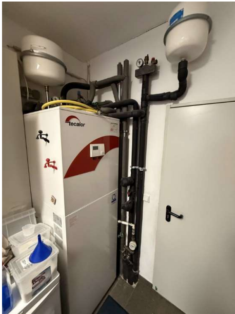
Heizungsanlage (Erdwärmepumpe)
