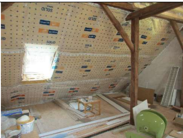
Begonnener Umbau DG mit Dämmung
