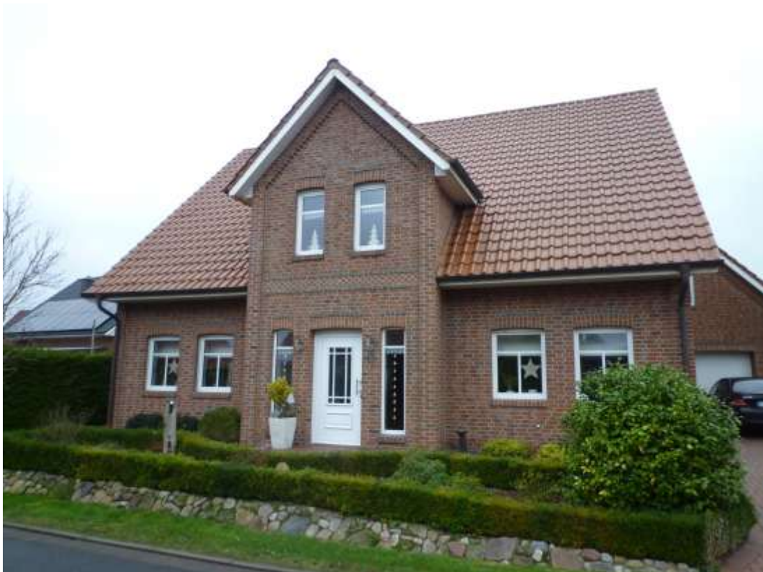
Frontansicht Wohnhaus / Ansicht aus südlicher Richtung
