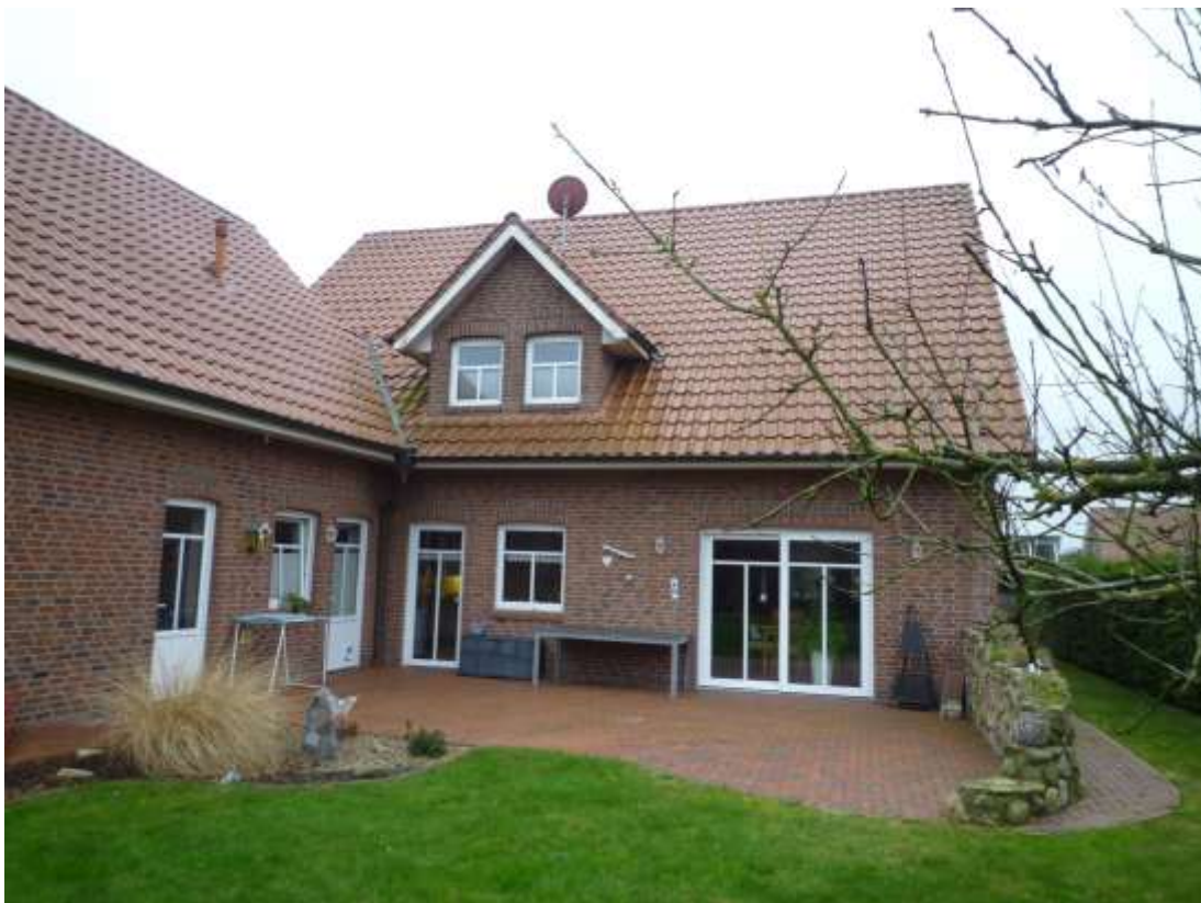
Rückansicht Wohnhaus / Ansicht aus nördlicher Richtung
