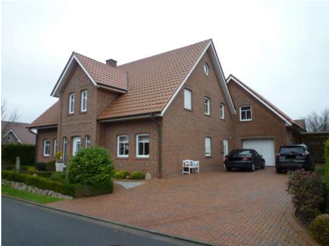
Front- / Seitenansicht gesamt / Ansicht aus südöstlicher Richtung
