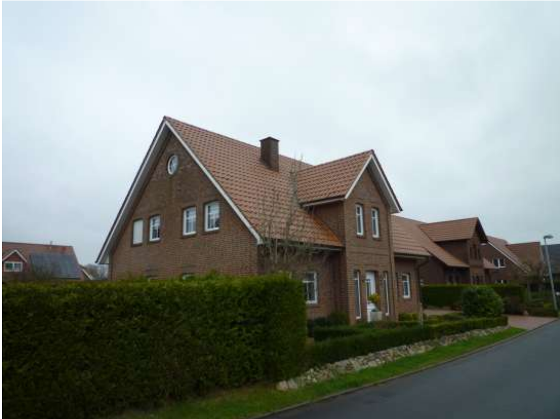
Front- Seitenansicht links / Ansicht aus südwestlicher Richtung
