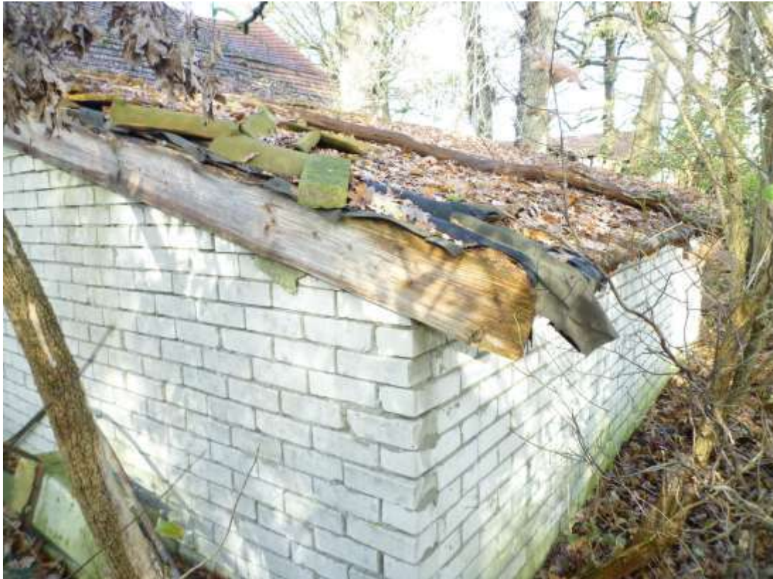
Rückansicht Öllager (ca. 1970) / Ansicht aus südlicher Richtung
