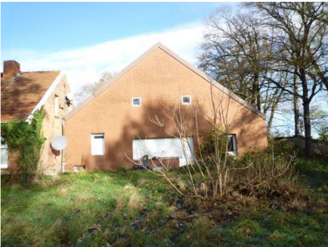
Wohn- und Wirtschaftsgebäude (ca. 1910) / Ansicht aus südlicher Richtung
