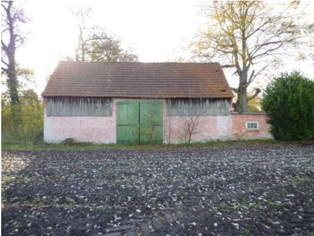
Garage und Scheune (ca. 1956) / Ansicht aus nördlicher Richtung
