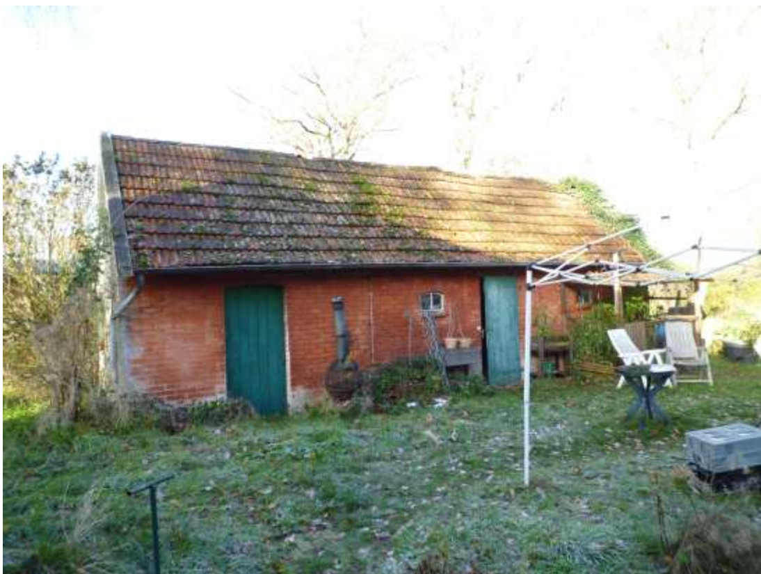
Hühnerstall (ca. 1910) / Ansicht aus östlicher Richtung
