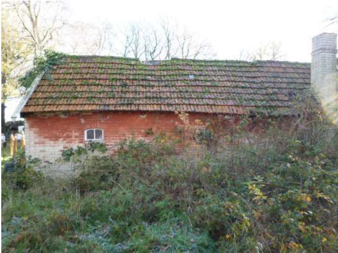
Hühnerstall (ca. 1910) / Ansicht aus westlicher Richtung
