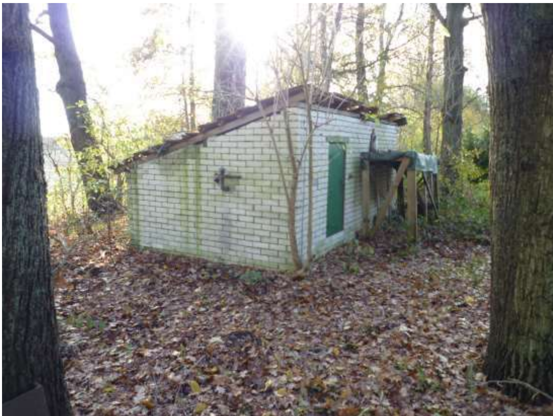
Öllager (ca. 1970) / Ansicht aus nördlicher Richtung
