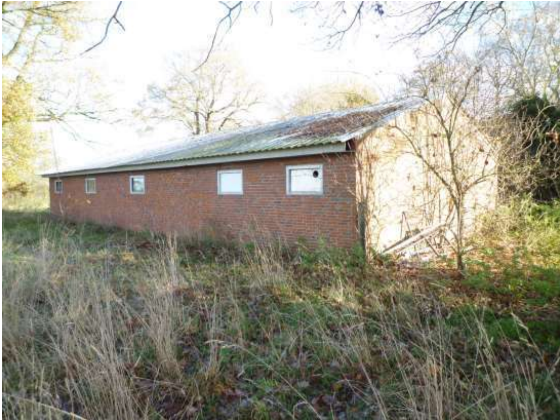
Schweinestall (ca. 1970) / Ansicht aus südwestlicher Richtung
