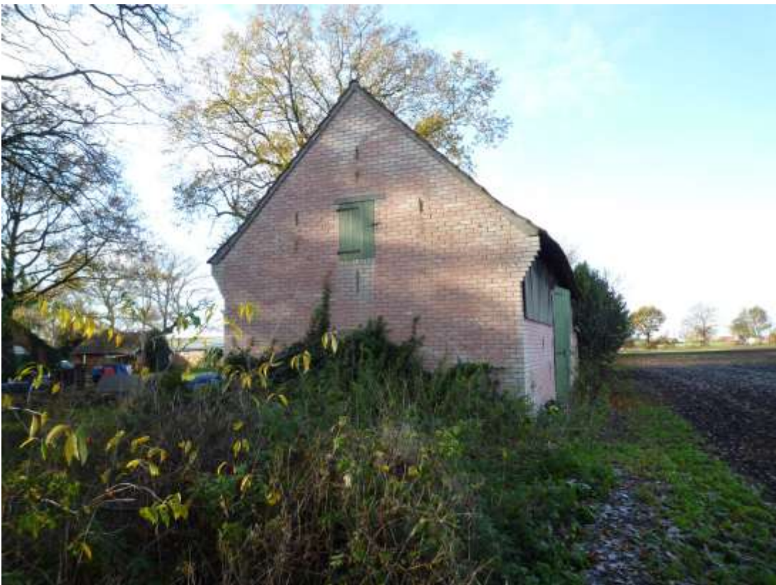
Scheune (ca. 1956) / Ansicht aus östlicher Richtung
