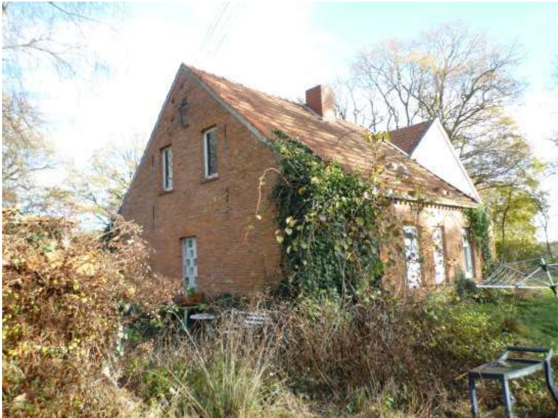
Seitenansicht Wohnhaus (ca. 1930) / Ansicht aus westlicher Richtung
