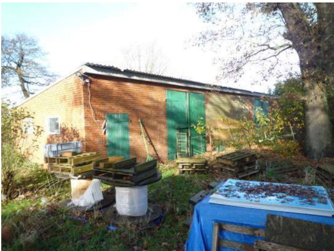
Scheune / Schleppergera (ca. 1970) / Ansicht aus südöstlicher Richtung
