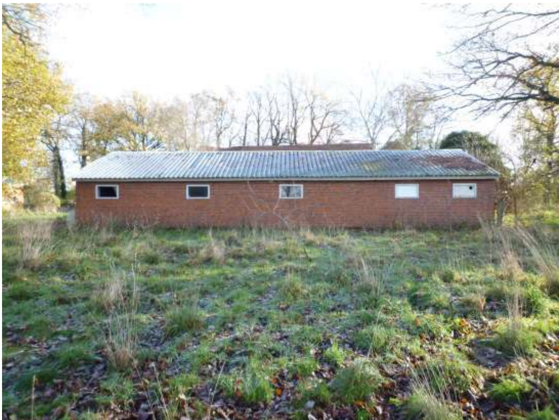
Schweinestall (ca. 1970) / Ansicht aus westlicher Richtung
