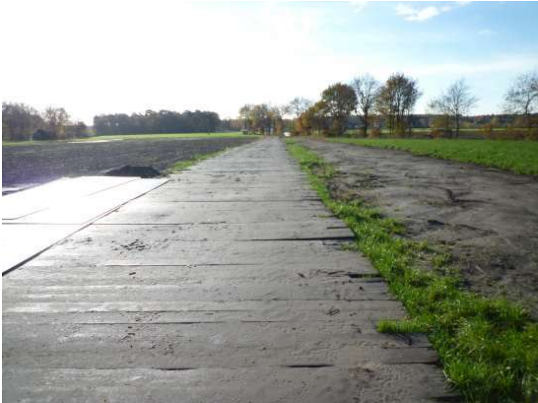
Grundstücksteilbereich „Ackerland“ / Fläche des Leitungsrecht „Amprion GmbH“
