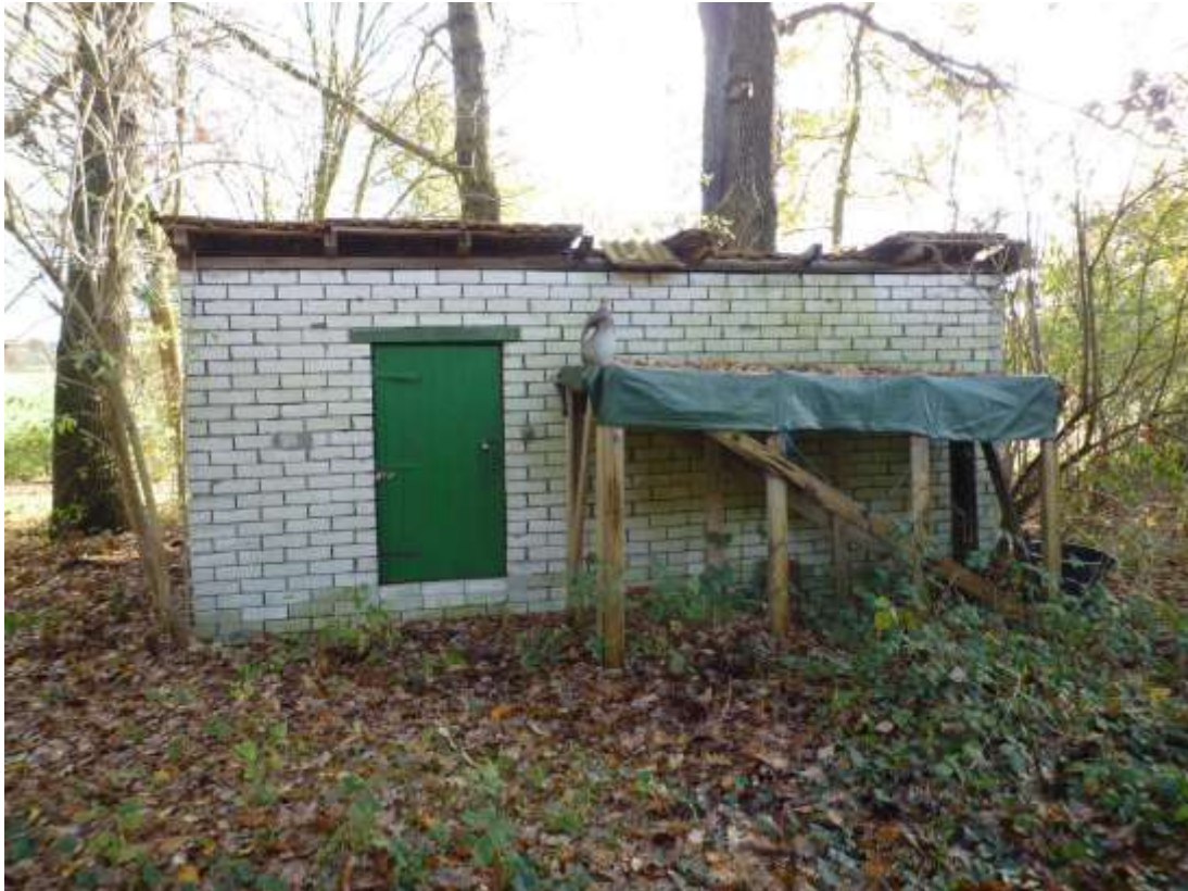
Frontansicht Öllager (ca. 1970) / Ansicht aus westlicher Richtung
