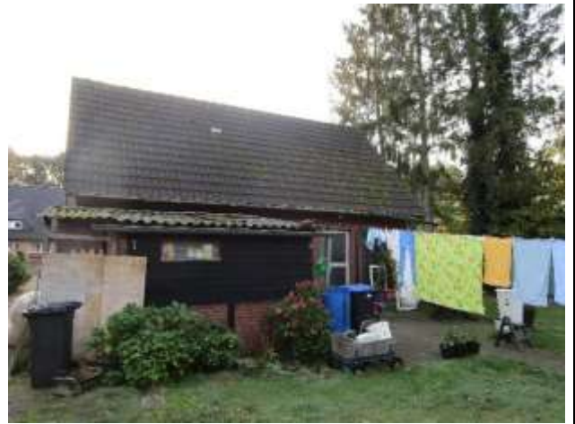
Unterstellschuppen am Stallgebäude
