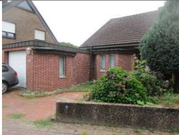
Ansicht Garage nördlich von der Straße
