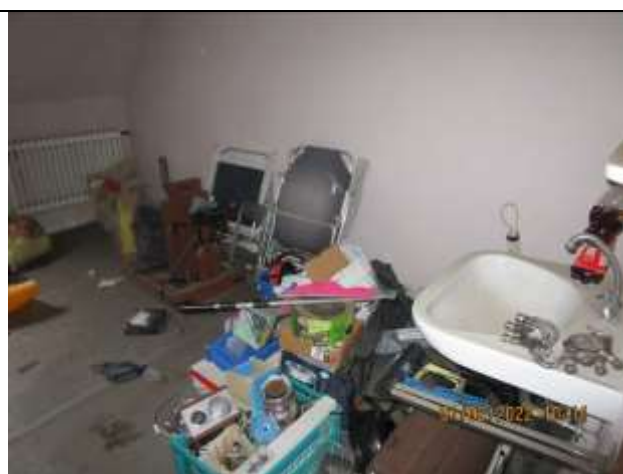
Raum im Dachgeschoss
