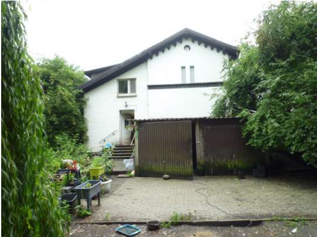
Frontansicht / Ansicht aus westlicher Richtung
