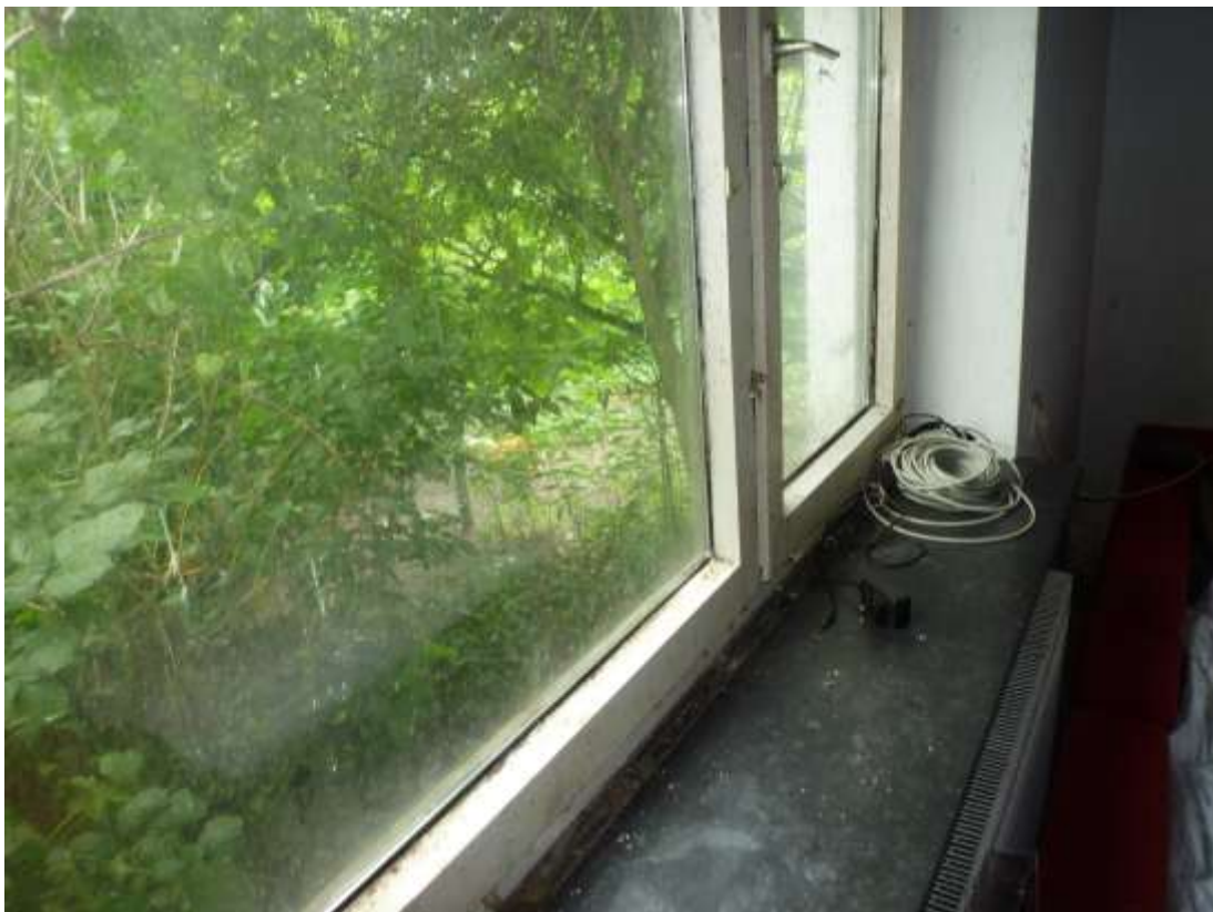
Zustand Fenster Erdgeschoss (Beispiel)
