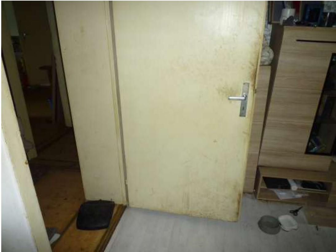
Zustand Innentüren (Beispiel)
