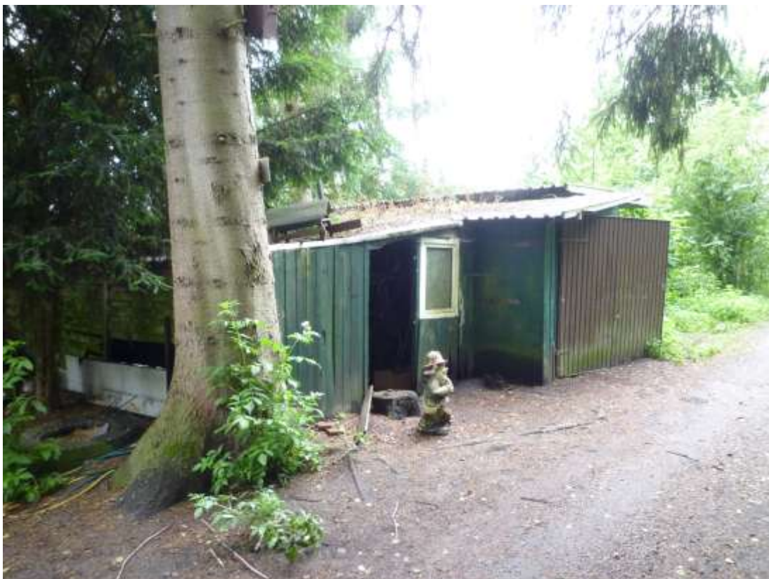
Frontansicht Schuppen vom Flurstück 48/1 (Nachgrundstück) aus
