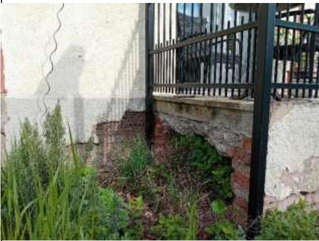
Putzschäden am Sockelmauerwerk des Wohnhauses und am Eingangstreppenpodest
