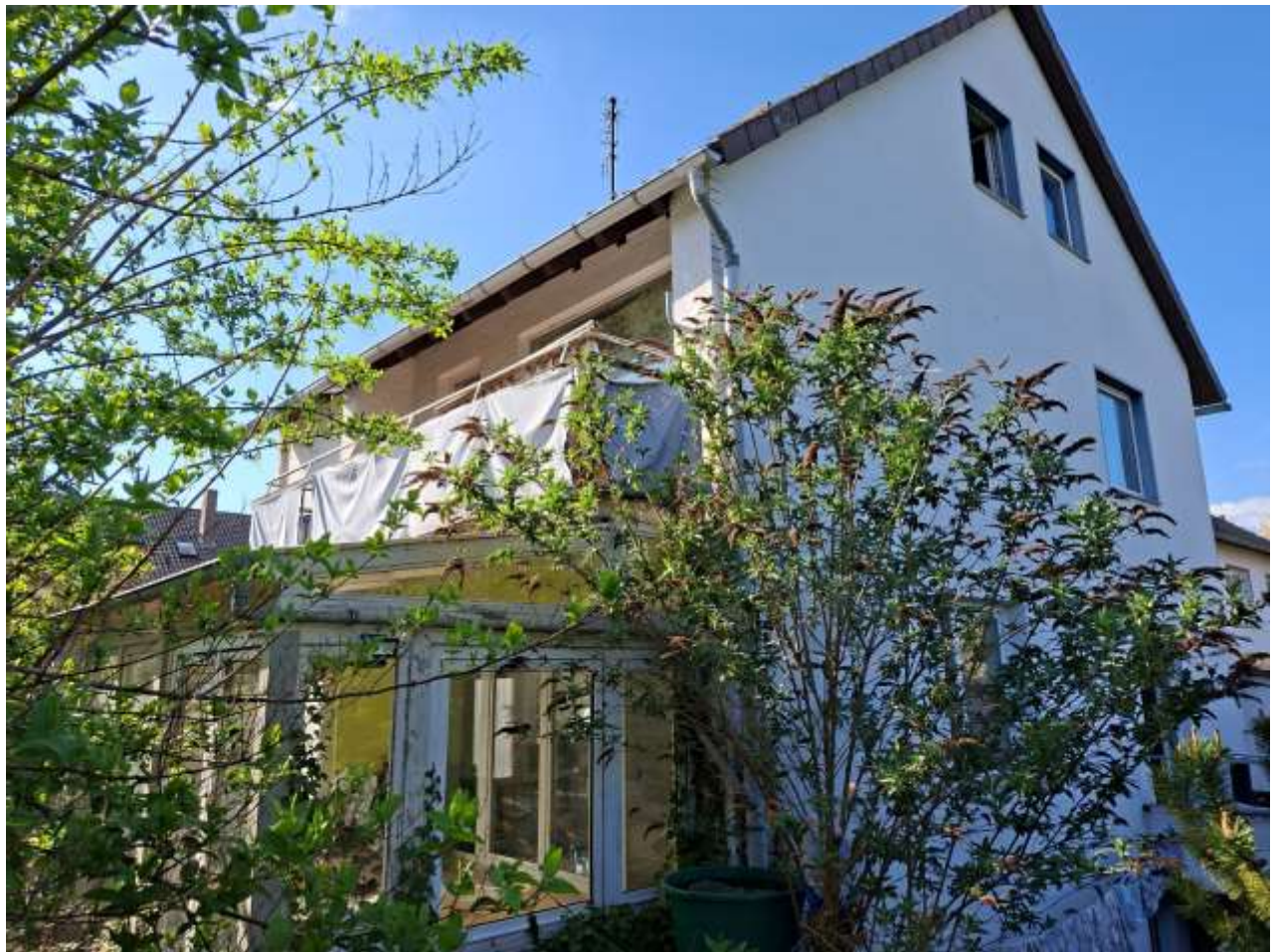
Ansicht der Südseite (Traufseite mit Wintergarten und Balkon) und des Ost-Giebels
