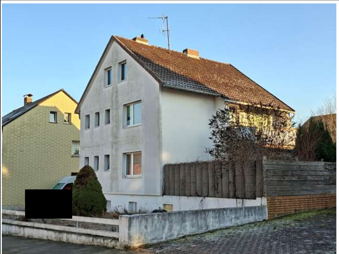
Ansicht der Südseite (Traufseite) und Ansicht der Westseite (Straßenseite)
