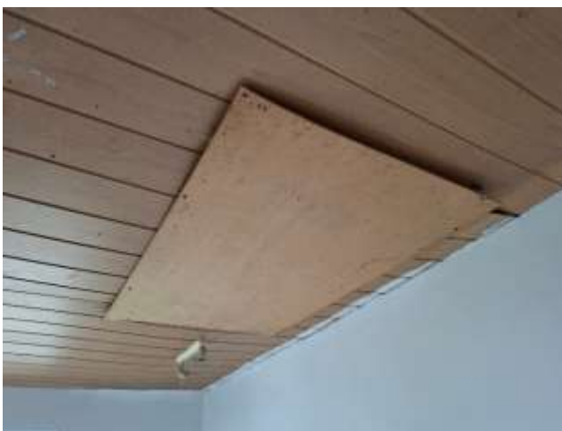
Die Luke zum Dachboden war mit einer Platte verschlossene und vernagelt. Der Dachboden war daher nicht zugänglich.
