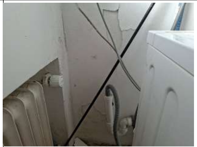
Duschraum: Schmutzablagerungen auf dem Fußboden sowie Abplatzungen des Anstrichs / Putzes aufgrund von Feuchtigkeitseinwirkung
