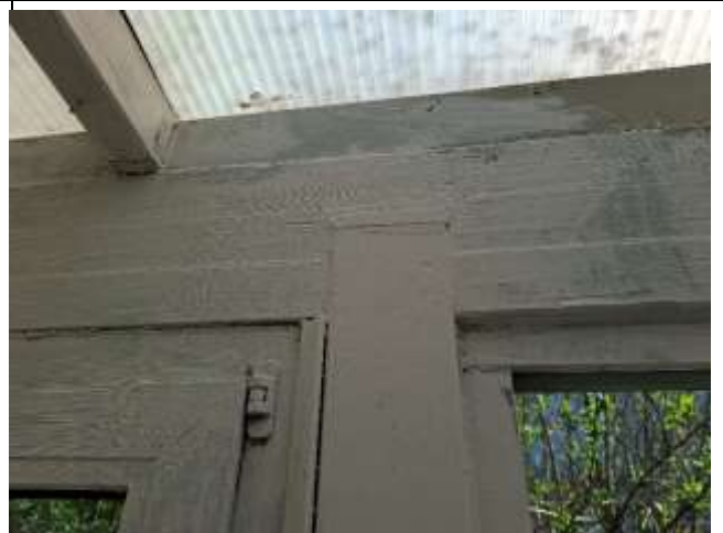
Wintergarten, Verwendung unterschiedlicher Baustoffe / Bauelemente: Kunststofffenster, welche nicht mehr richtig schließen, Glasbausteine, Holzbauteile, Gipskartonbauplatten, provisorischer Anstrich auf unterschiedlichen Oberflächen
