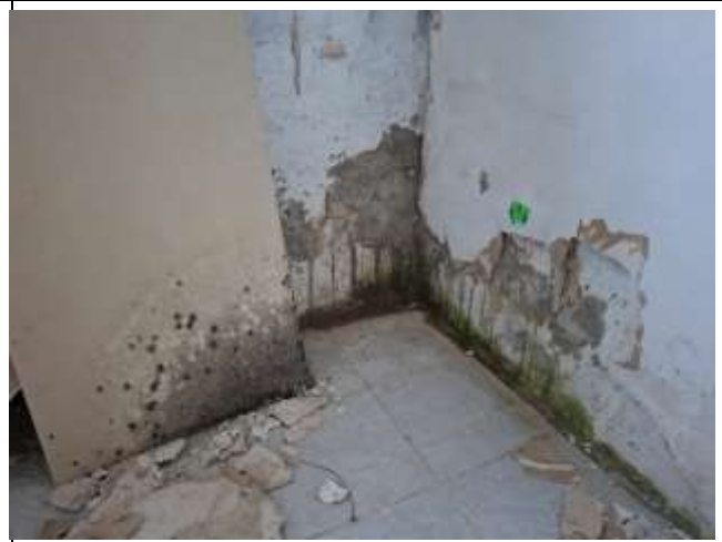
Feuchte bis nasse Wandsockelbereiche mit entsprechenden Putzschäden
