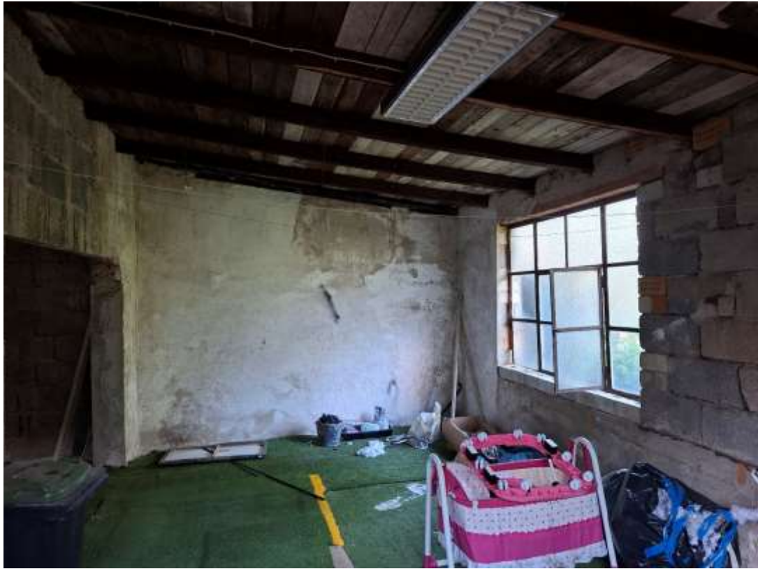
Nicht genehmigter Anbau an die Garage Die Wände sind teilweise unverputzt und weisen Feuchtigkeitsschäden auf.
