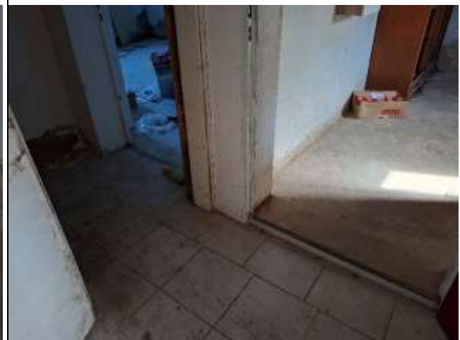
Verschmutzte Fußböden im Keller, Putzschäden an nassen / feuchten Wandsockeln
