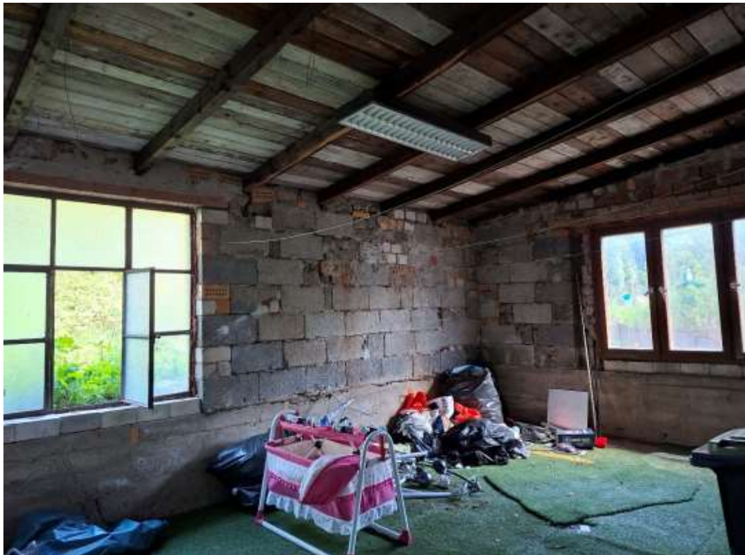
Nicht genehmigter Anbau an die Garage Die Wände sind teilweise unverputzt und weisen Feuchtigkeitsschäden auf.
