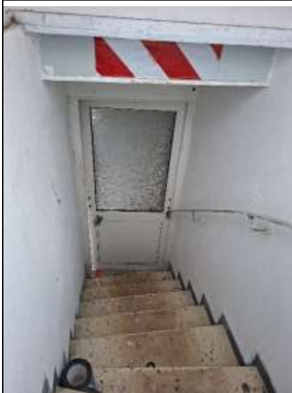
Abgang vom Flur zum Keller
