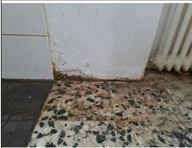
Duschraum: Schmutzablagerungen auf dem Fußboden sowie Abplatzungen des Anstrichs / Putzes aufgrund von Feuchtigkeitseinwirkung
