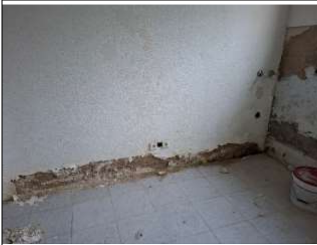
Feuchte bis nasse Wandsockelbereiche mit entsprechenden Putzschäden
