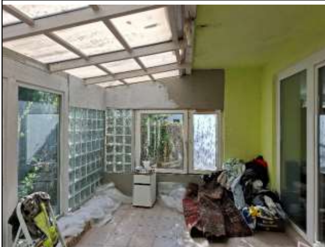
Wintergarten, Verwendung unterschiedlicher Baustoffe / Bauelemente: Kunststofffenster, welche nicht mehr richtig schließen, Glasbausteine, Holzbauteile, Gipskartonbauplatten, provisorischer Anstrich auf unterschiedlichen Oberflächen
