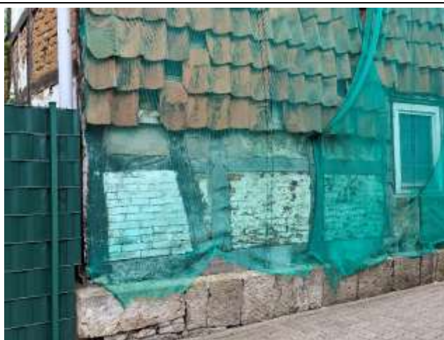
Fehlende Ziegel im Fassadenbehang, fehlender Putz der Gefachfelder, morschtes Schwellholz
