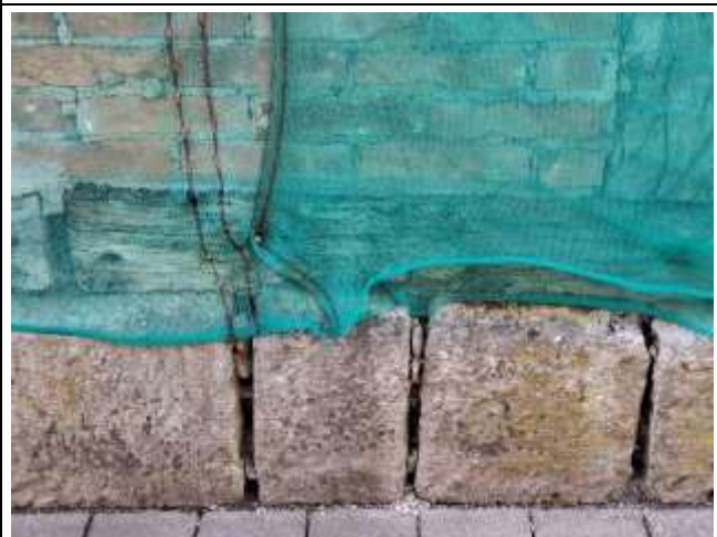
Fehlende Ziegel im Fassadenbehang, fehlender Putz der Gefachfelder, morschtes Schwellholz
