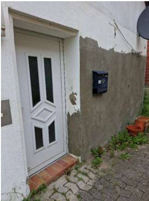
Nachgeputzte Hauswand am Anbau
