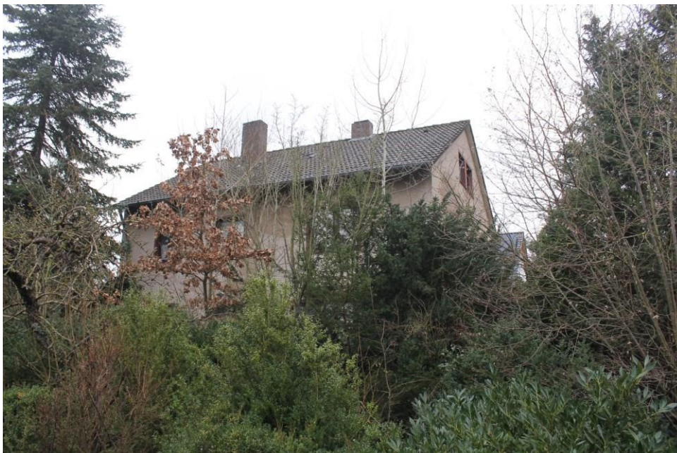
Ansicht des Bewertungsobjekts aus südwestlicher Richtung
