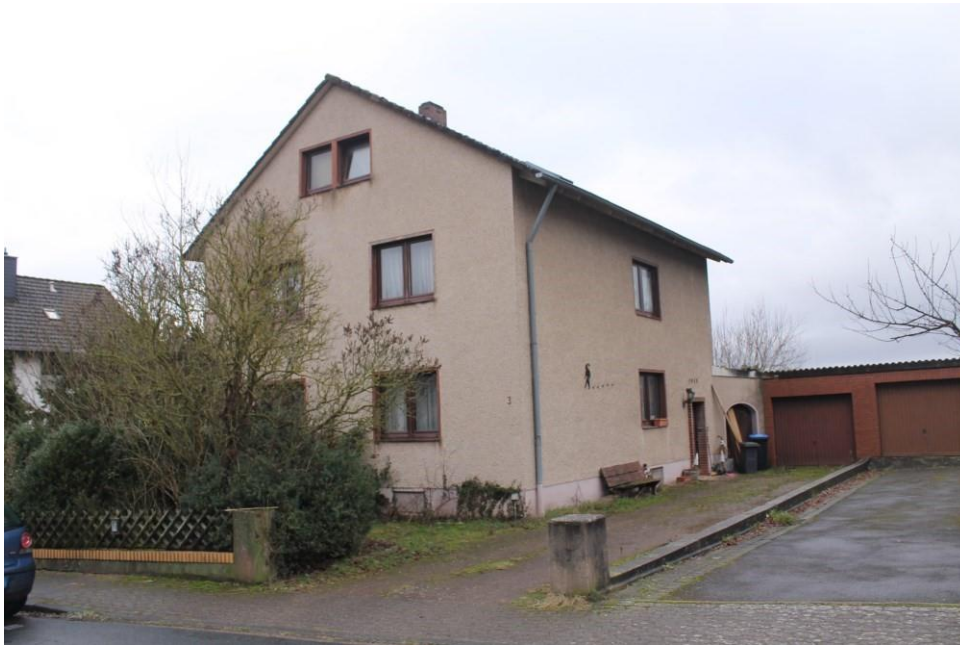
Ansicht des Bewertungsobjekts aus südöstlicher Richtung
