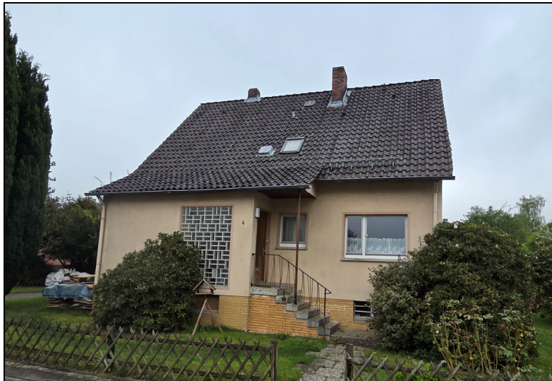
Bild 1 oben: Straßenfront- und Eingangsseite
