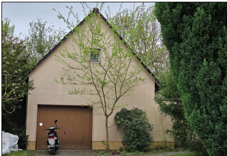
Bild 3 oben: Garage / ehem. Stall
