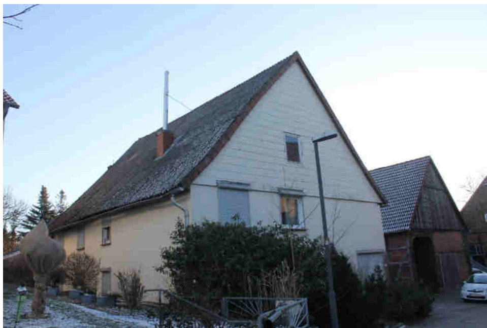
Wohnhaus aus nordwestlicher Richtung
