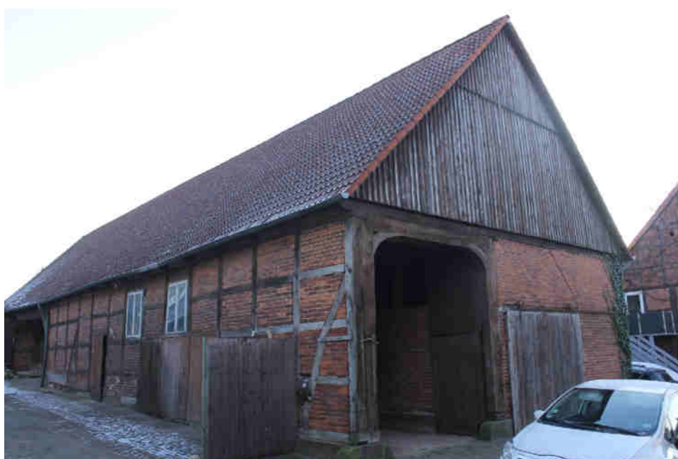
Scheune aus nordwestlicher Richtung
