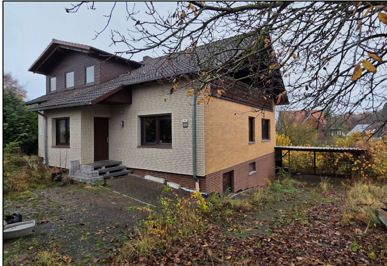
Bild 1 oben: Straßenfront- und Eingangsseite
