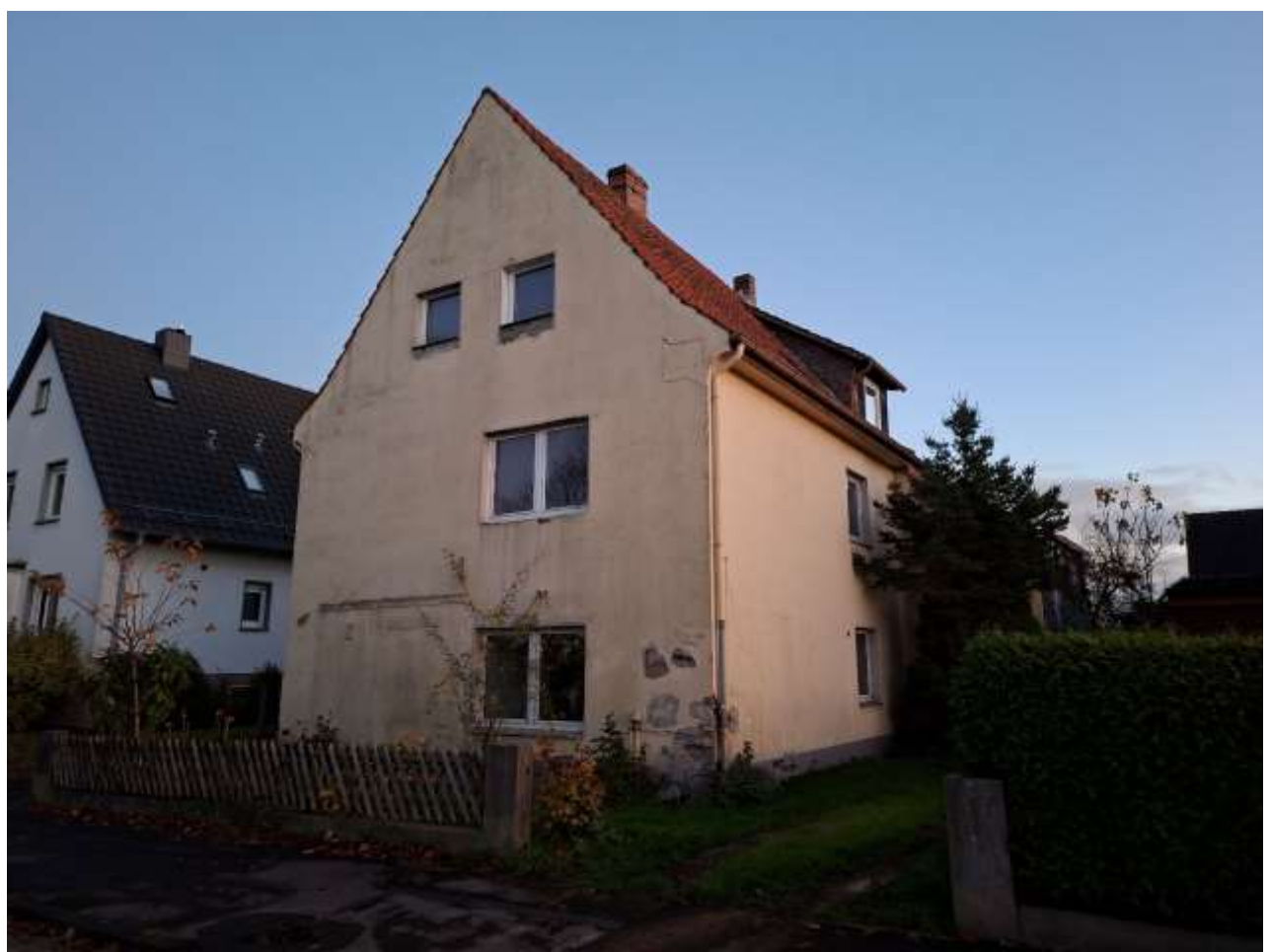
Ansicht von Norden (Giebel- und Straßenseite) sowie Ansicht der Westseite (Traufseite)
