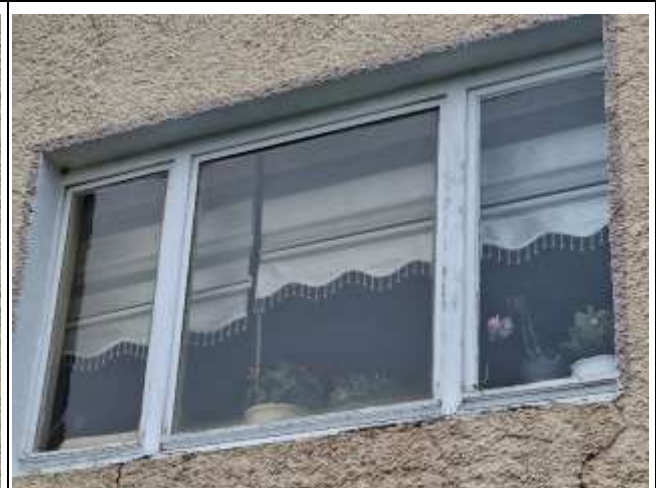
Defekte Holzfenster in der zur OG-Wohnung des Hinterhauses gehörenden Fassade
