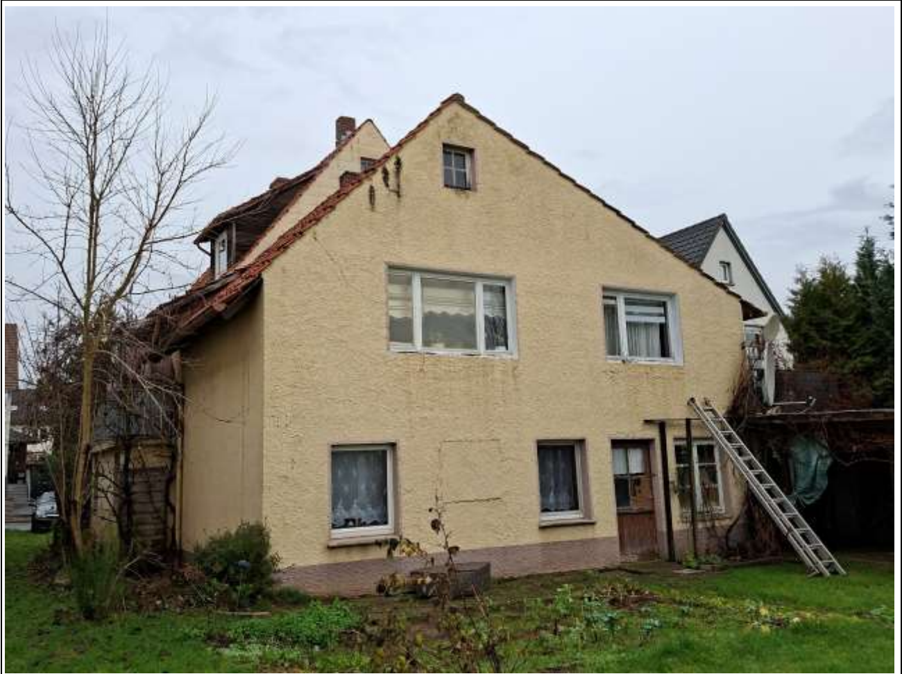
Ansicht von Süden (Giebel- und Gartenseite)
