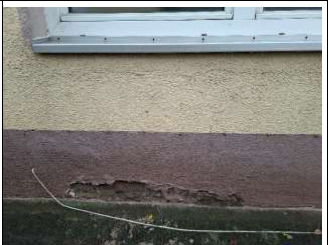
Schäden an der Fassade durch Feuchtigkeitseinwirkung: Abplatzungen und Rissbildung
