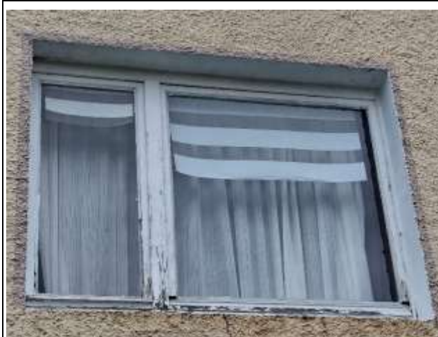
Defekte Holzfenster in der zur OG-Wohnung des Hinterhauses gehörenden Fassade
