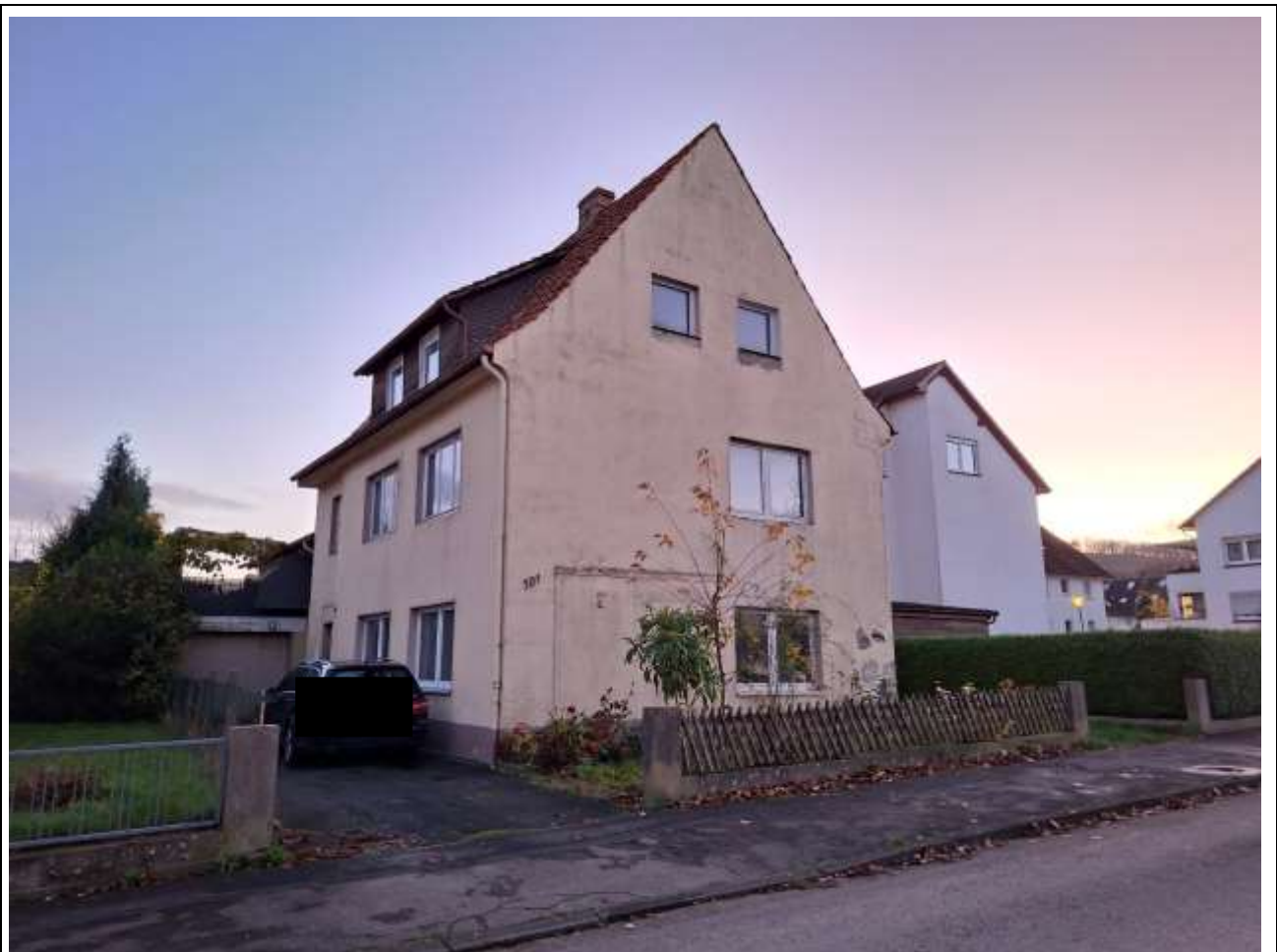
Ansicht von Norden (Giebel- und Straßenseite) sowie Ansicht der Ostseite (Traufseite und Hofauffahrt)
