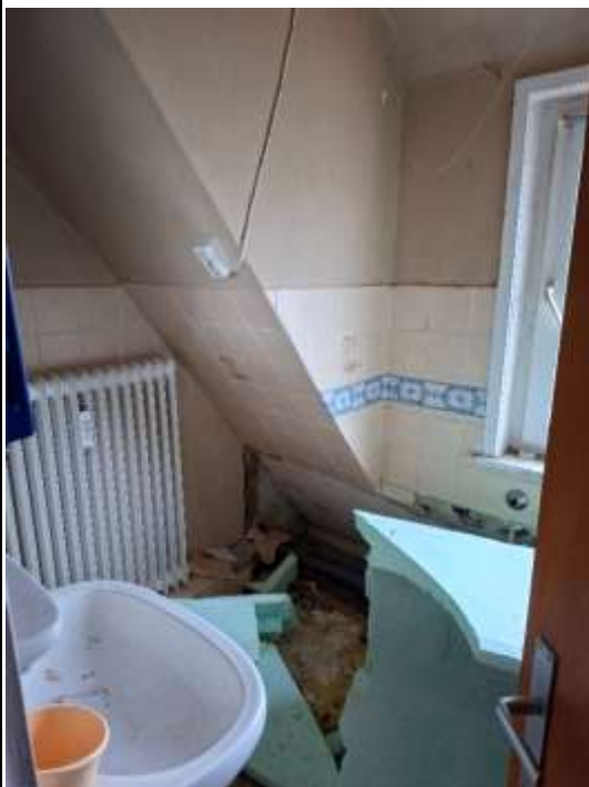
Bad – mit ausgebauter Badewanne und zerstörtem Wannenträger
