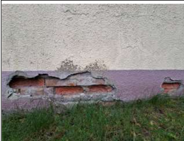
Schäden an der Fassade durch Feuchtigkeitseinwirkung: Abplatzungen und Rissbildung
