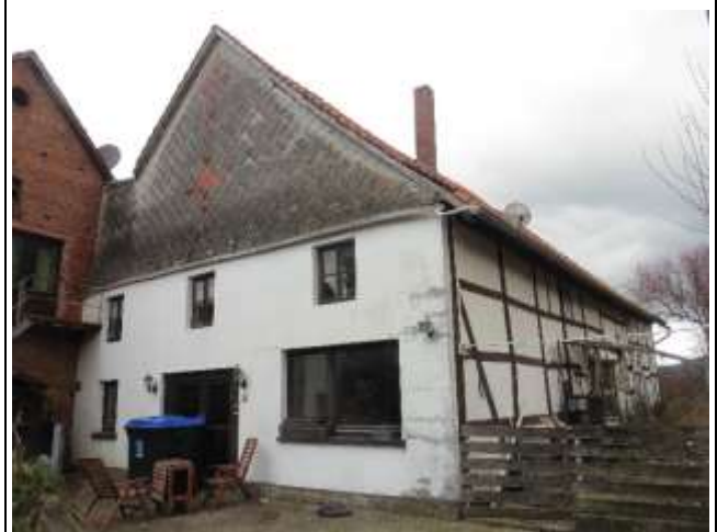
Ursprüngl. Wohnhaus als Fachwerkhaus = Gebäude 3: Südfassade (Giebelseite) und Ostfassade (Traufseite)
