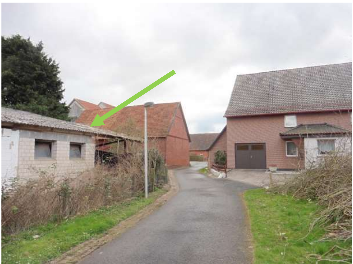
Dörfliche Mischnutzung an der Straße „Im Sack“ – grüner Pfeil: Geflügelstall = Gebäude 5 (nur teilweise als Schafstall genehmigt)
