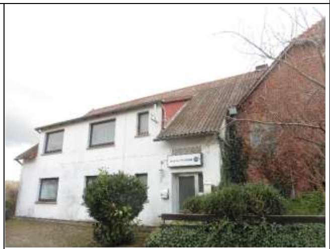
Zweifamilienhaus (ehemalige Scheune) = Gebäude 1: Ansicht von Westen
