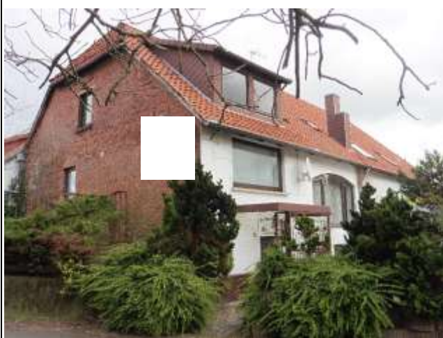
Gaststätte / Pension = Gebäude 2: Südfassade (Traufseite) und Westfassade (Walmgiebelseite)
