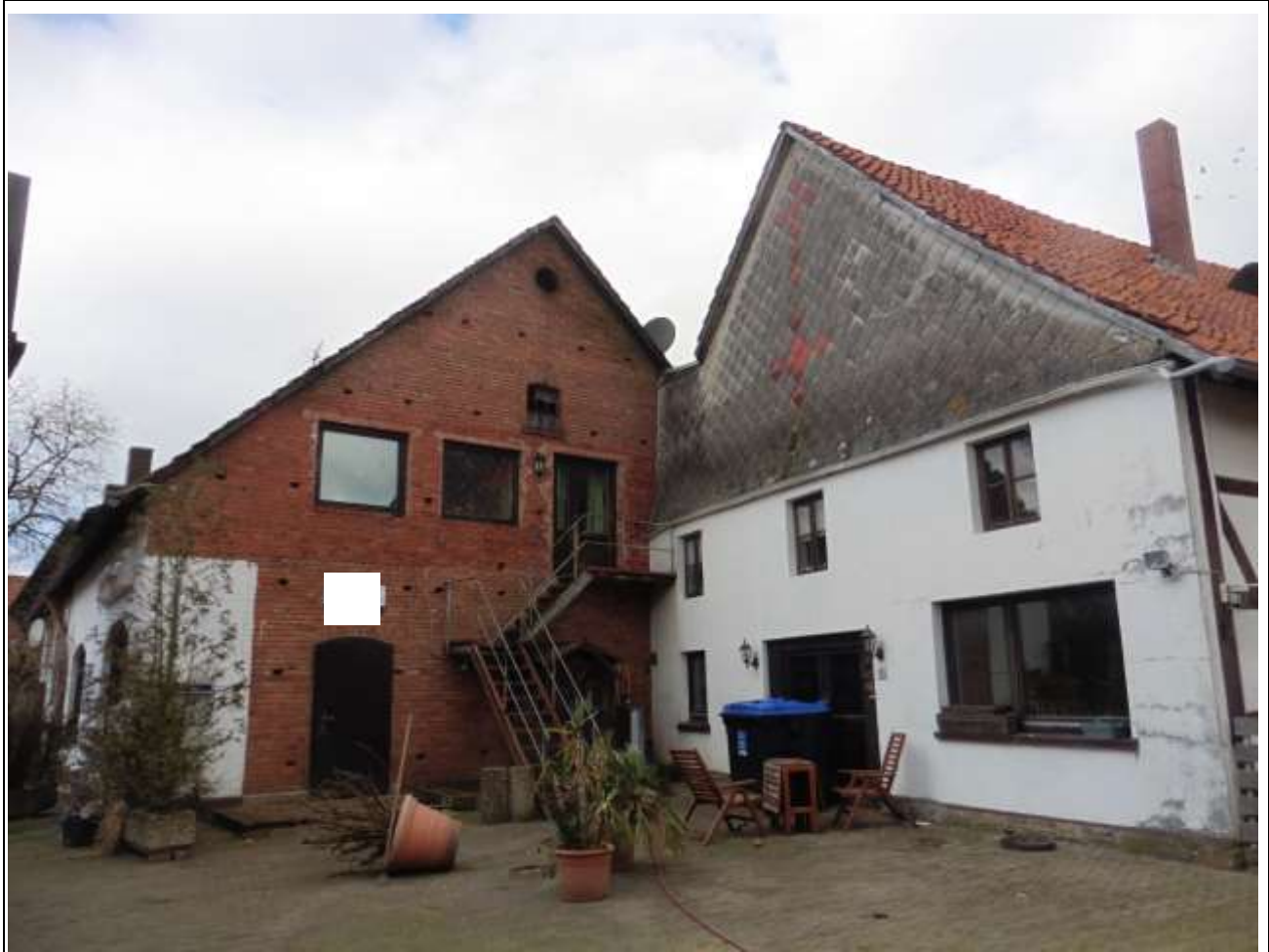
Rechts: Ursprüngliches Wohnhaus als Fachwerkhaus (Gebäude 3): Ansicht von Süden Links: Gaststätte / Pension, ehemalige Scheune (Gebäude 2): Ansicht von Osten
