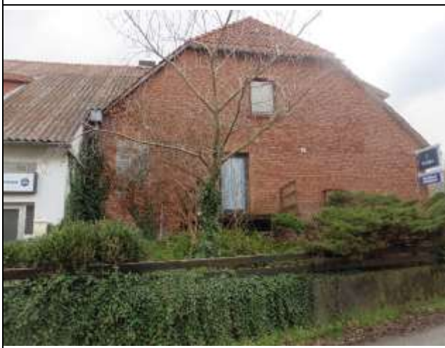
Gaststätte / Pension = Gebäude 2: Ansicht von Westen
