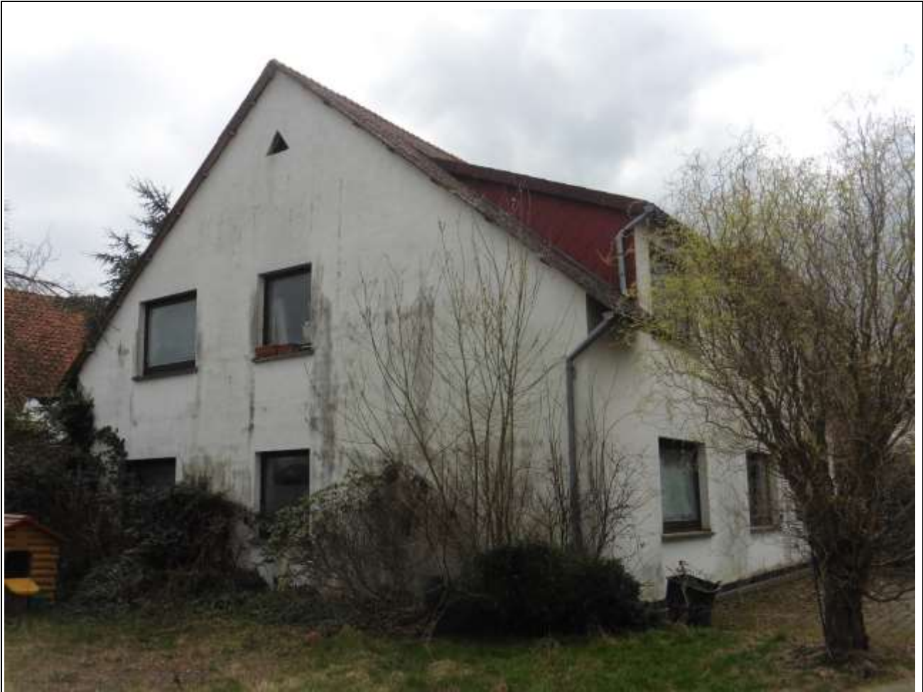
Zweifamilienhaus (ehemalige Scheune) = Gebäude 1 Nordfassade (Giebelseite) und Westfassade (Traufseite)
