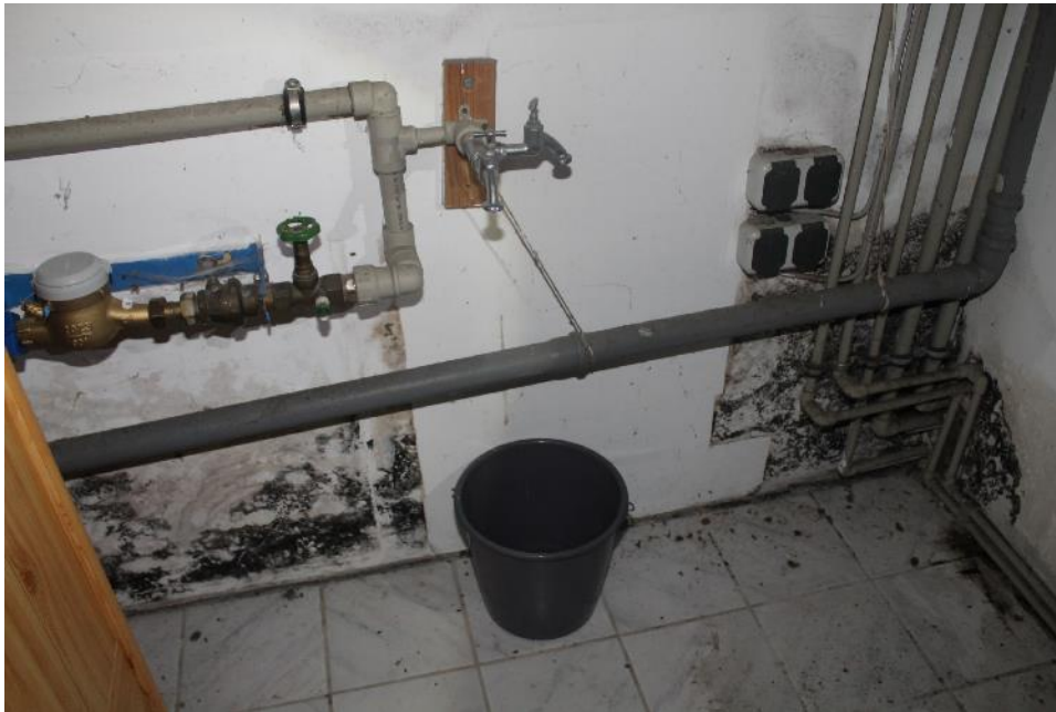
Bild 11: Schimmelbeaufschlagung im Keller exemplarisch
