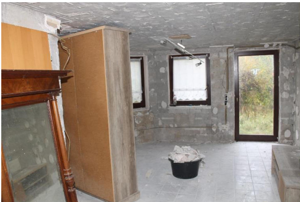
Bild 14: Rohbauähnlicher Zustand des Hobbyraums im KG
