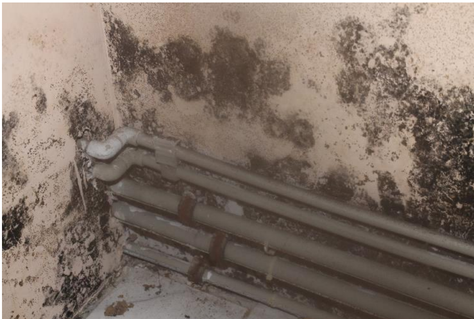
Bild 12: Schimmelbeaufschlagung im Keller exemplarisch
