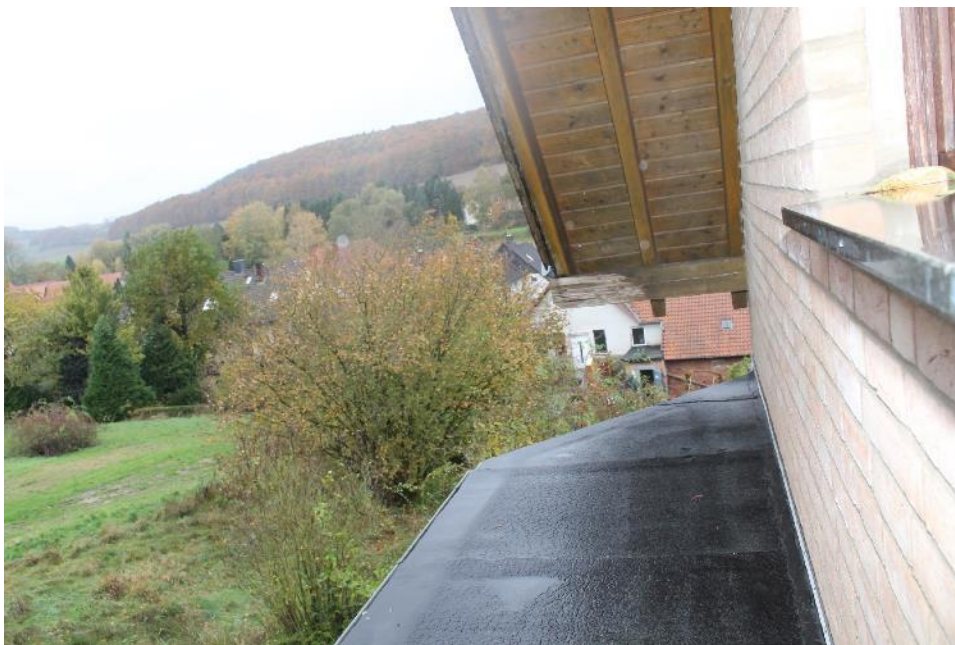
Bild 8: Fehlende Absturzsicherung und Belag der Loggia im OG
