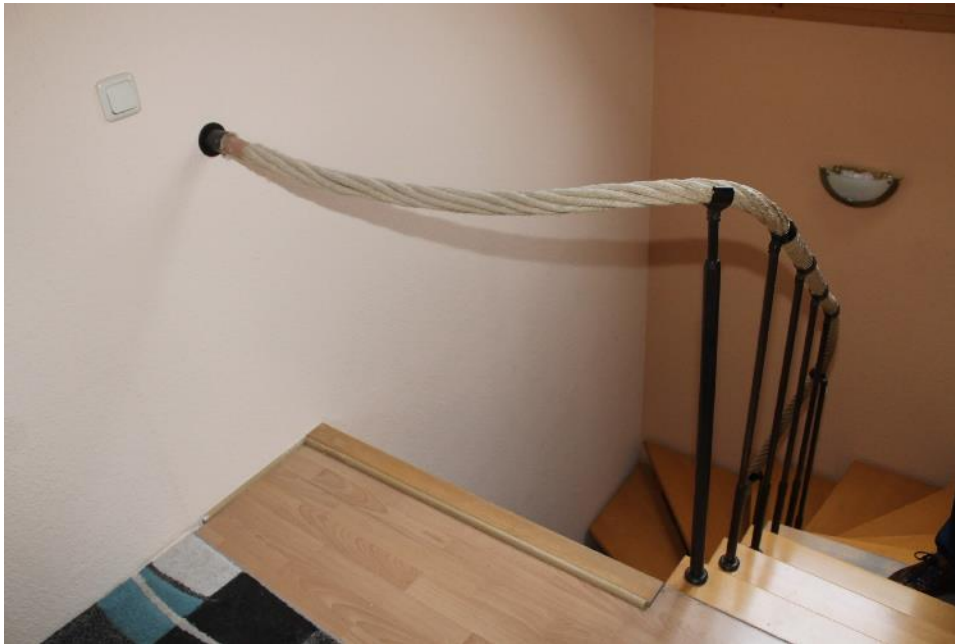
Bild 7: Mangelhafte Absturzsicherung im Treppenhaus OG
