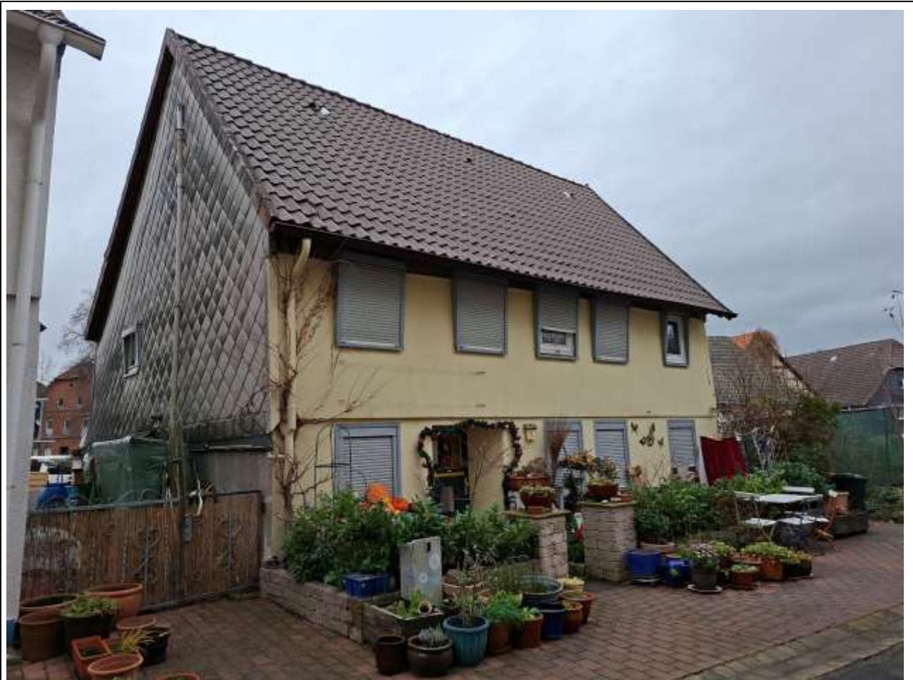
Ansicht von Süd-Osten (Trauf- und Hauseingangsseite) Ansicht von Süd-Westen (Giebel- und Hofseite)
