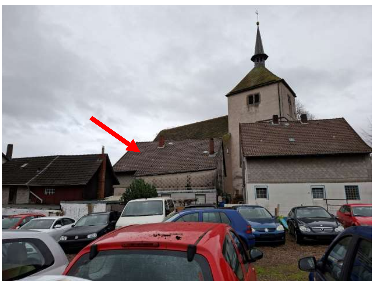
Umliegende Bebauung und Nutzung: Kirche, Ein- u. Zweifamilienhäuser, Gewerbe (z.B. Gebrauchtwagenhandel) Roter Pfeil: Bewertungsobjekt
