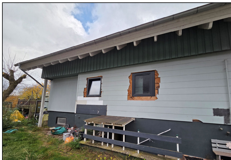
Bild 2 oben: Seitenansicht mit Zugang KG
