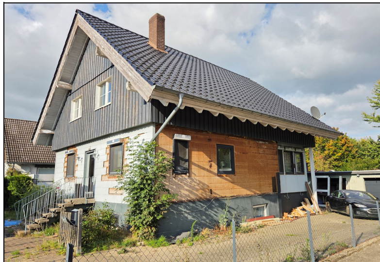
Bild 1 oben: Straßenfront- und Eingangsseite , im Hintergrund Doppelgarage
