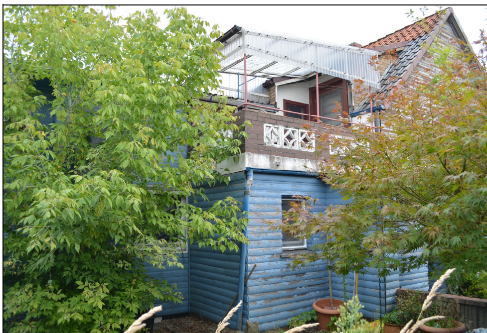
Bild 2 unten: Seitenansicht Anbau
