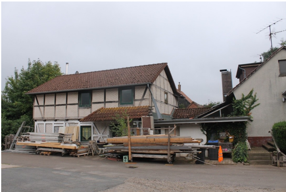
Ansicht des Bewertungsobjekts aus nordwestlicher Richtung
