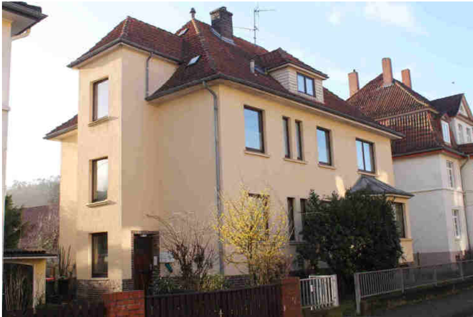
Ansicht des Bewertungsobjekts aus nordöstlicher Richtung
