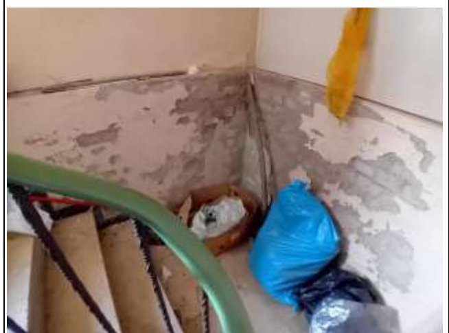
Putzschäden durch Feuchtigkeit an der Außenwand des Kellerabgangs
