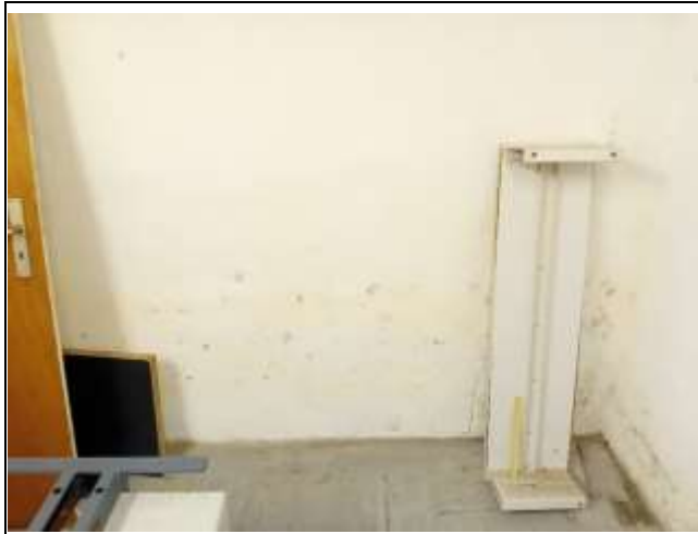
Schimmelpilzbildung an einer Kellerwand
