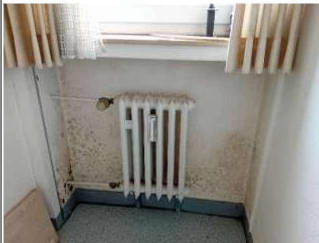
Schimmelpilzbildung an der Heizkörpernische im Raum des ehemaligen Geldautomats
