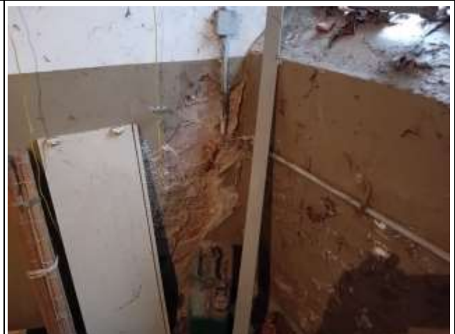
Putzschäden durch Feuchtigkeit an Kelleraußen- und Innenwänden
