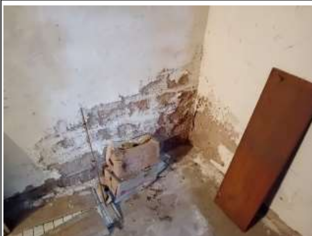
Putzschäden durch Feuchtigkeit an Kelleraußen- und Innenwänden
