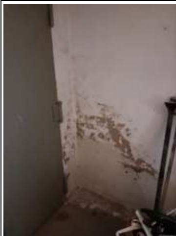
Putzschäden durch Feuchtigkeit an einer Kelleraußenwand
