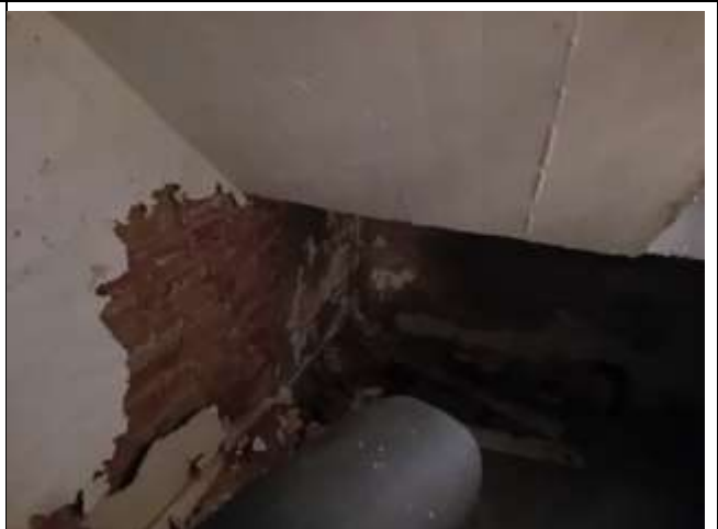
Putzschäden durch Feuchtigkeit im Bereich der Kellertreppe
