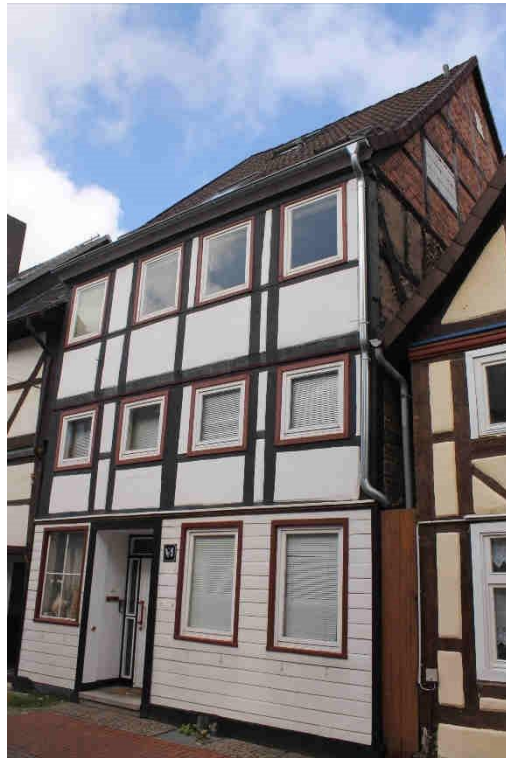
Ansicht Wohnhaus aus nord-östlicher Richtung
