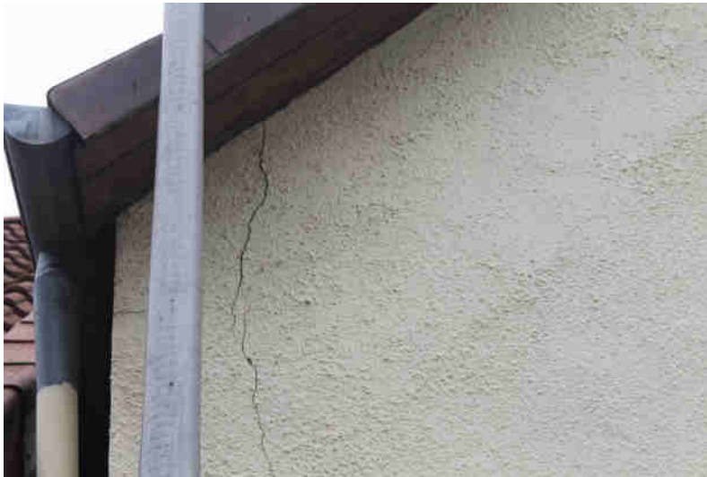
Riss an süd-westlicher Gebäudeecke im Bereich Ortgang
