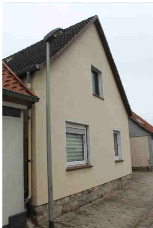
Ansicht des Bewertungsobjekts aus südwestlicher Richtung
