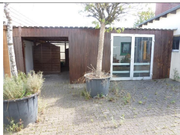
überdachter Lagerraum, Ansicht von Süden
