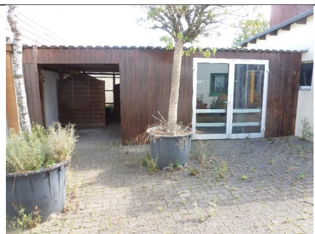
überdachter Lagerraum, Ansicht von Süden
