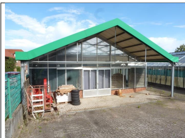
Ansicht von Osten
