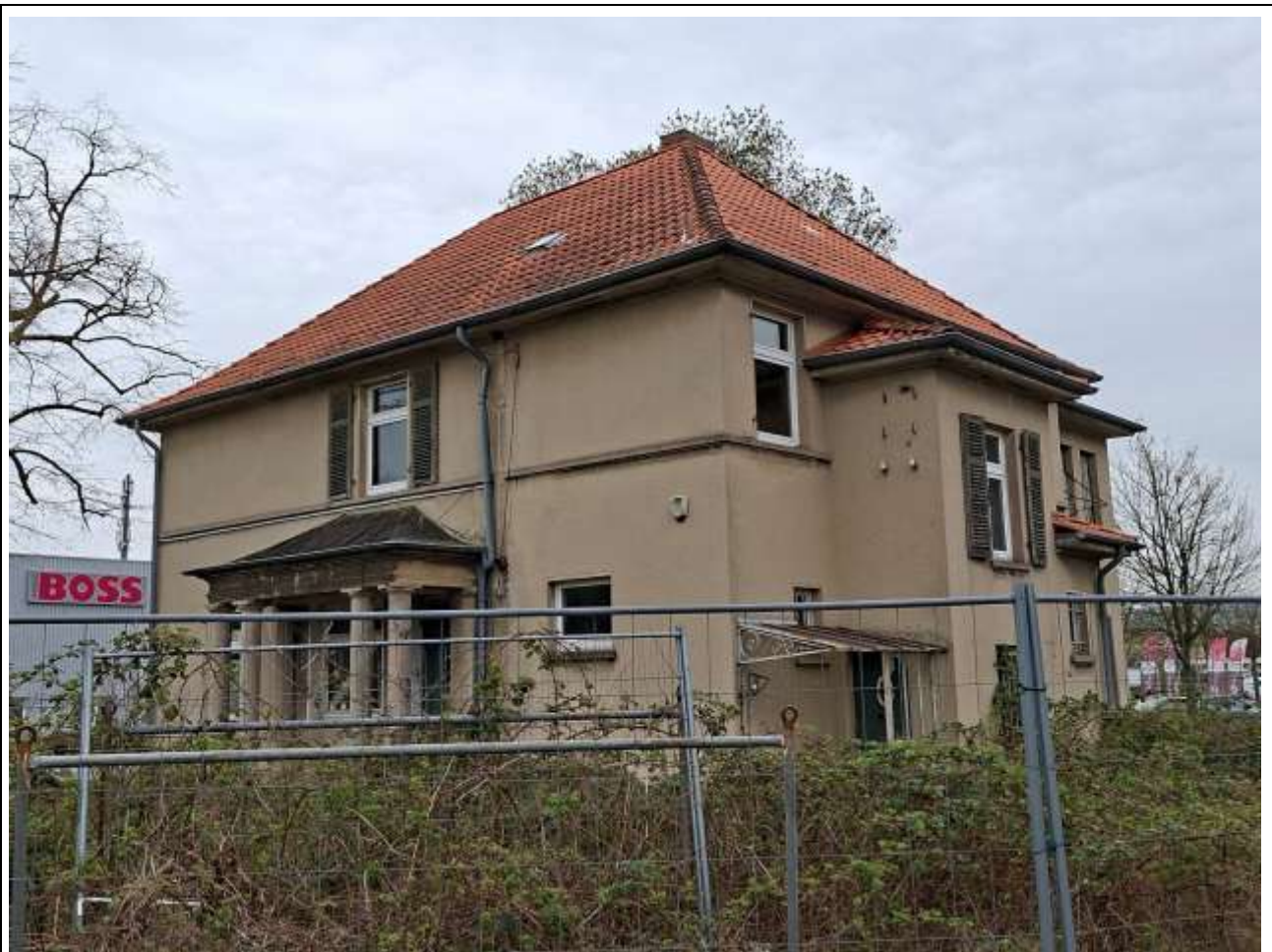
Ansicht der Nord-West-Seite (Terrassenerker im EG) und Ansicht der Süd-West-Seite (Hauseingangsseite mit Treppenhauseinbau)
