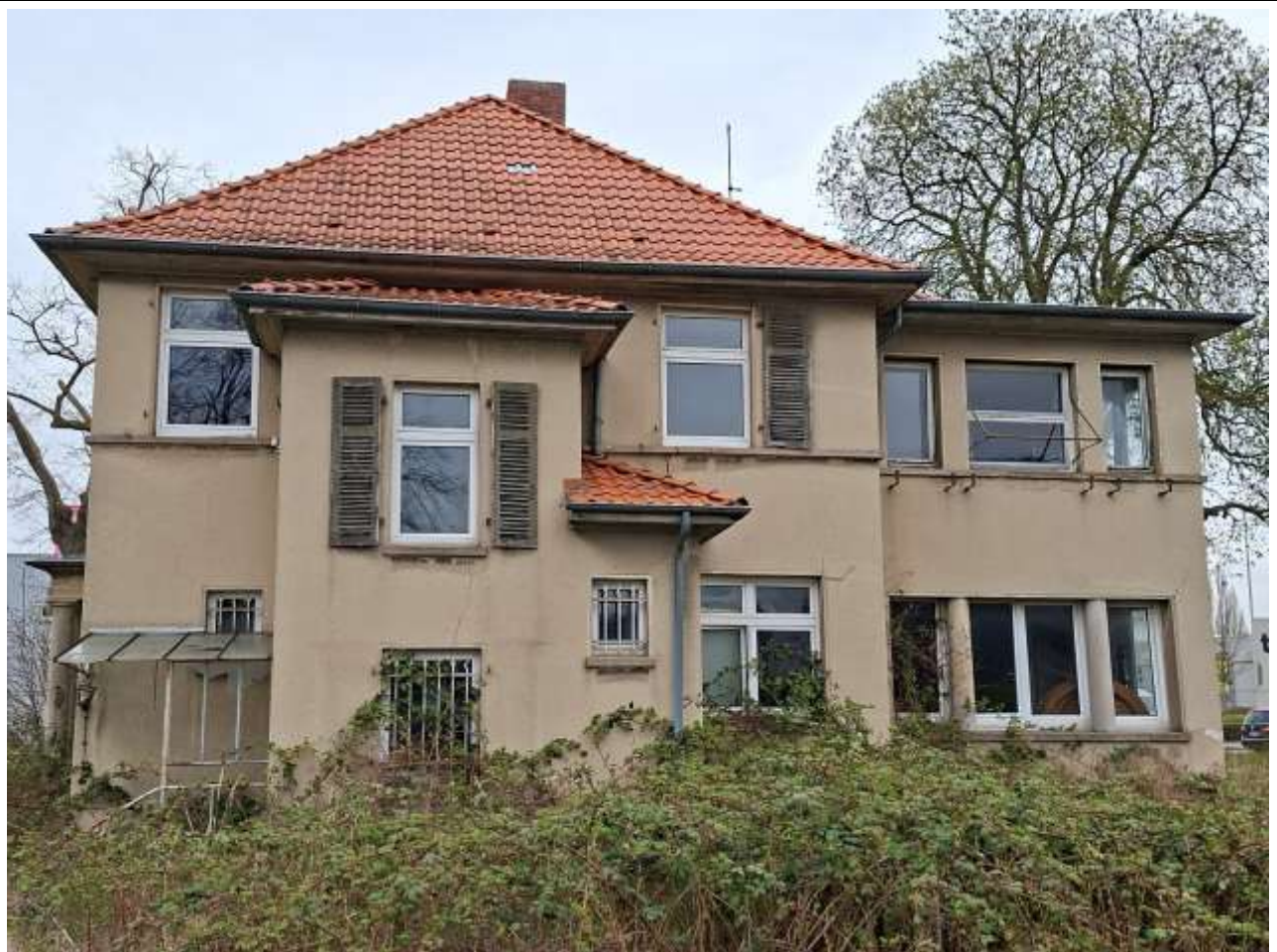
Ansicht der Süd-West-Seite (Hauseingangsseite mit Treppenhausanbau)
