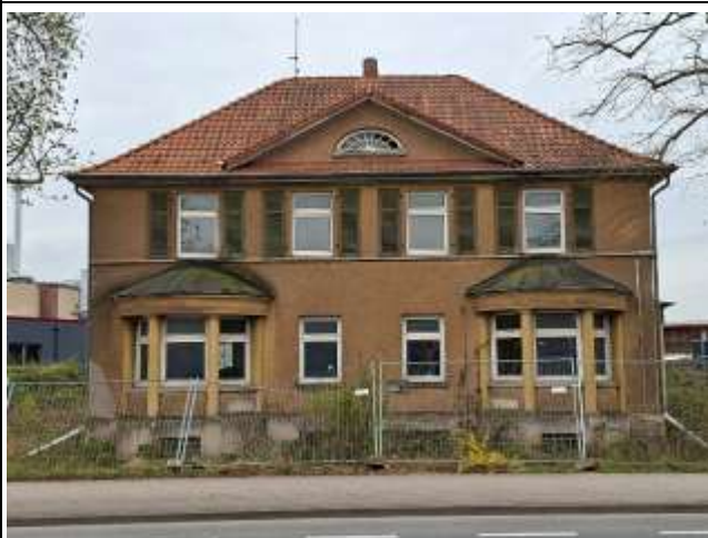
Ansicht der Nord-Ost-Seite (Straßenseite zur Bundesstraße 1)
