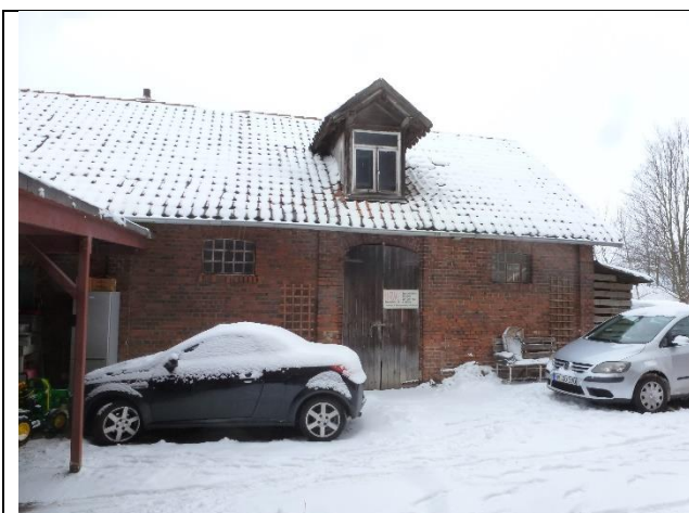
Werkstatt, Ansicht von Süden
