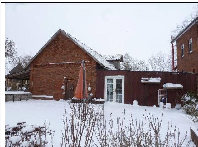
Werkstatt und Carport, Ansicht von Westen
