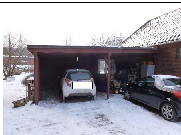
Carport, Ansicht von Osten
