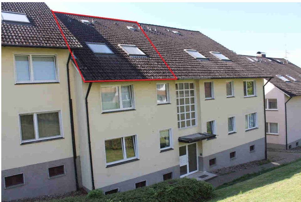
Ansicht des Bewertungsobjekts aus nordöstlicher Richtung
