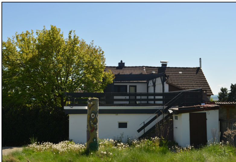
Bild 3 oben: Rückseite mit Garage
