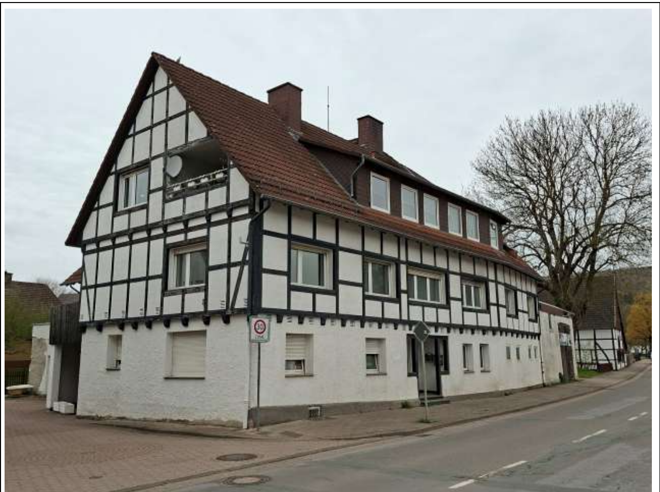
Ansicht von Osten (Trauf- und Straßenseite) sowie Ansicht der Südseite (Giebelseite)
