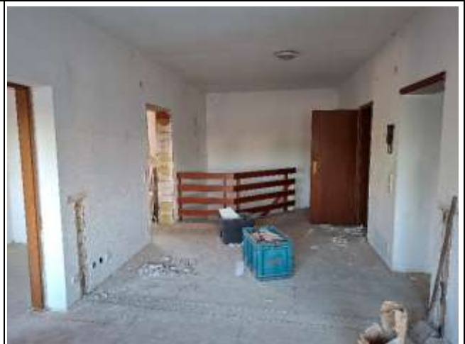
Blick Richtung Treppenaustritt
