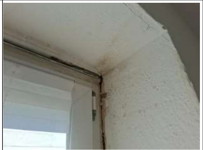
Schimmelpilzbildung an der Innenlaibung des selben Fensters
