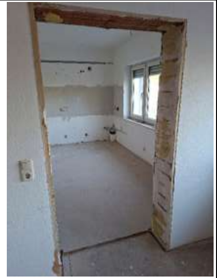
Blick von der Diele in die Küche
