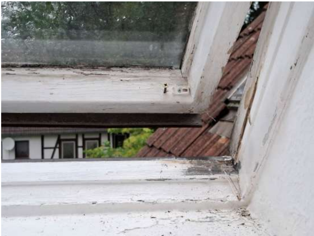
Dachflächenfenster in der Wohnung Nr. 3 mit Schäden durch Nässeeinwirkung
