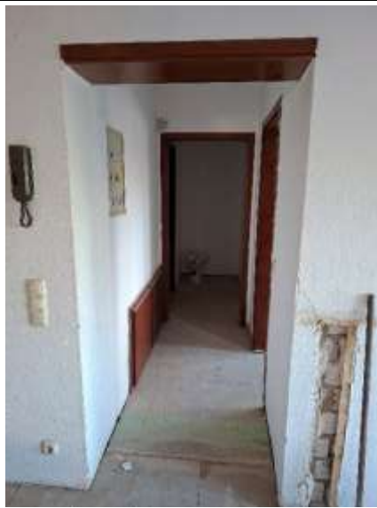
Blick von der Diele in den Flur
