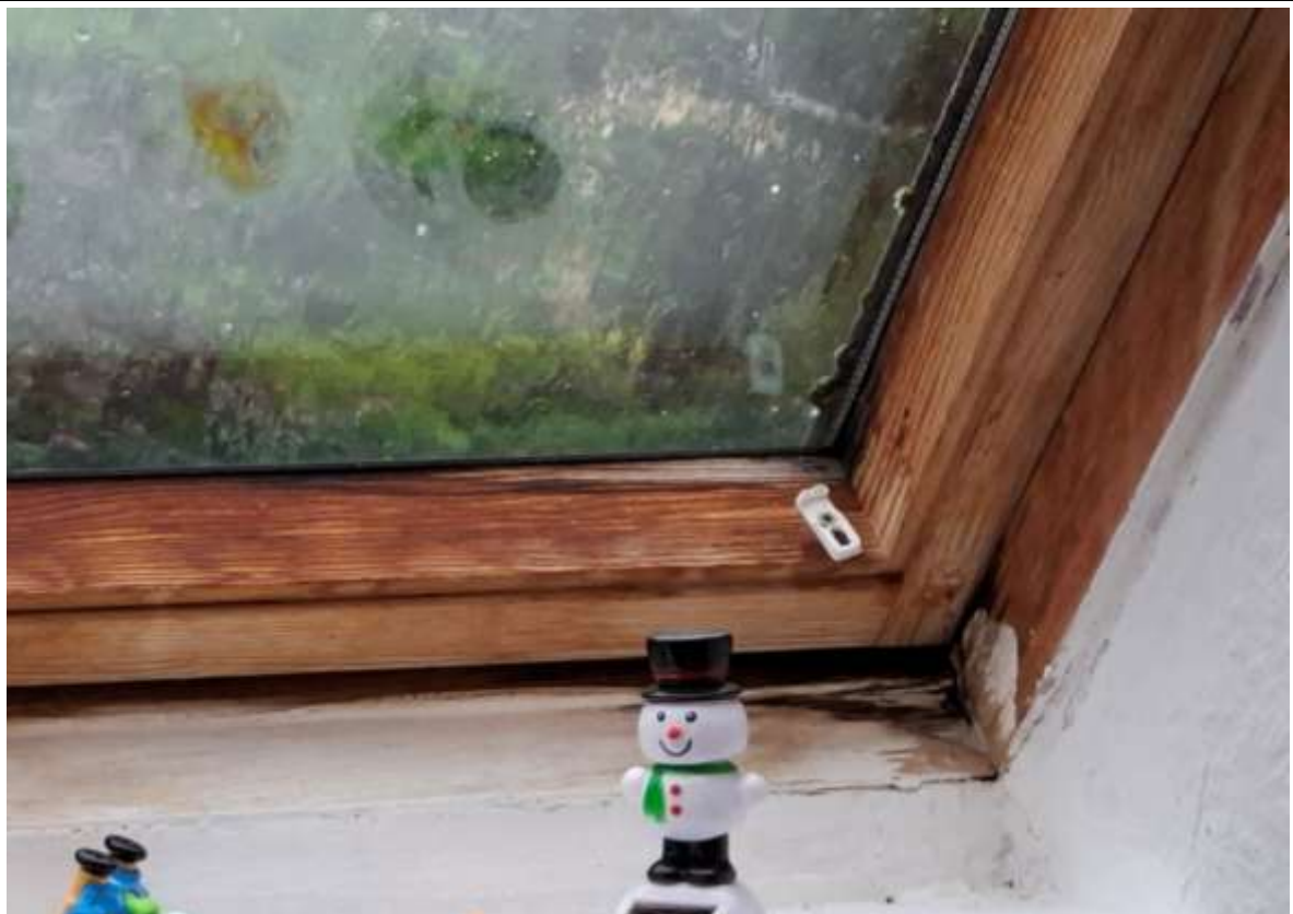
Dachflächenfenster in der Wohnung Nr. 3 mit Schäden durch Nässeeinwirkung
