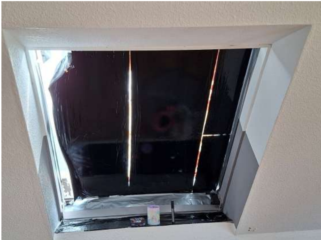
Unten: abgeklebte nicht zu öffnende Dachfenster (2 Stück) mit Festverglasung in Whg. Nr. 6
