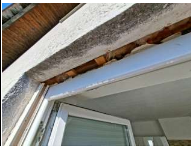
Offene Fensterlaibung an einem ehemaligen Rollladenkasten
