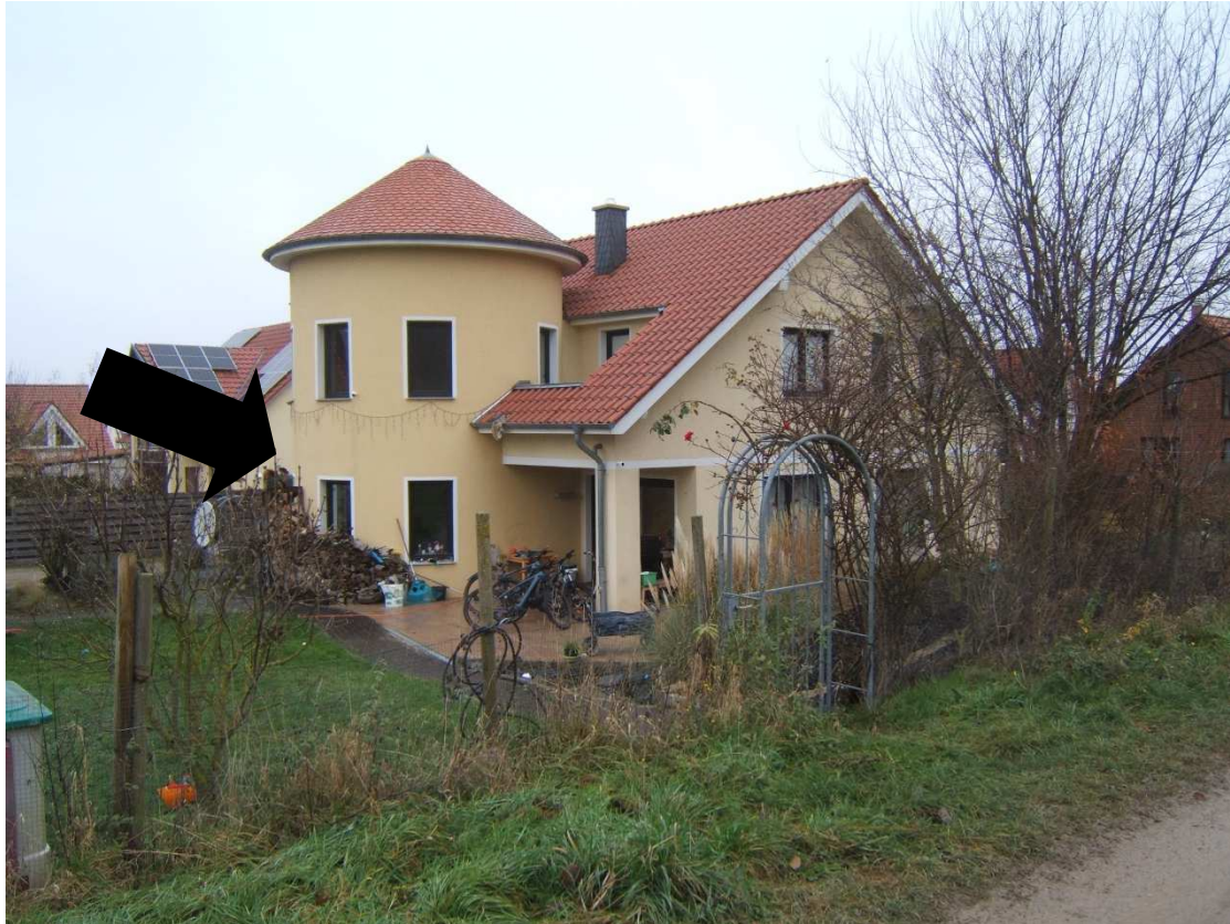
Foto 2, Ostansicht von der Feldseite
