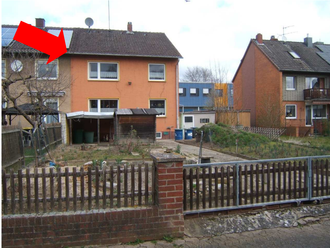
Foto 2 Ansicht von der Gartenseite
