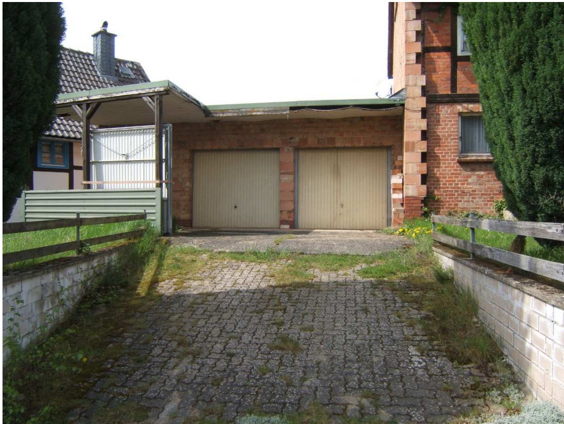
Foto 2 Ostansicht von der Kantor-Bode-Straße, Garagenzufahrt
