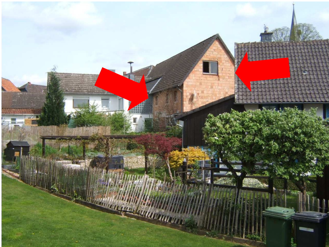
Foto 3 Westansicht von der Straße Schmiedebrink
