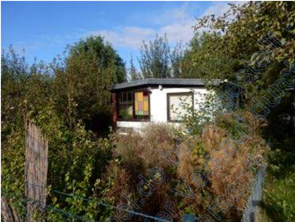
Ansicht aus Richtung Südosten
