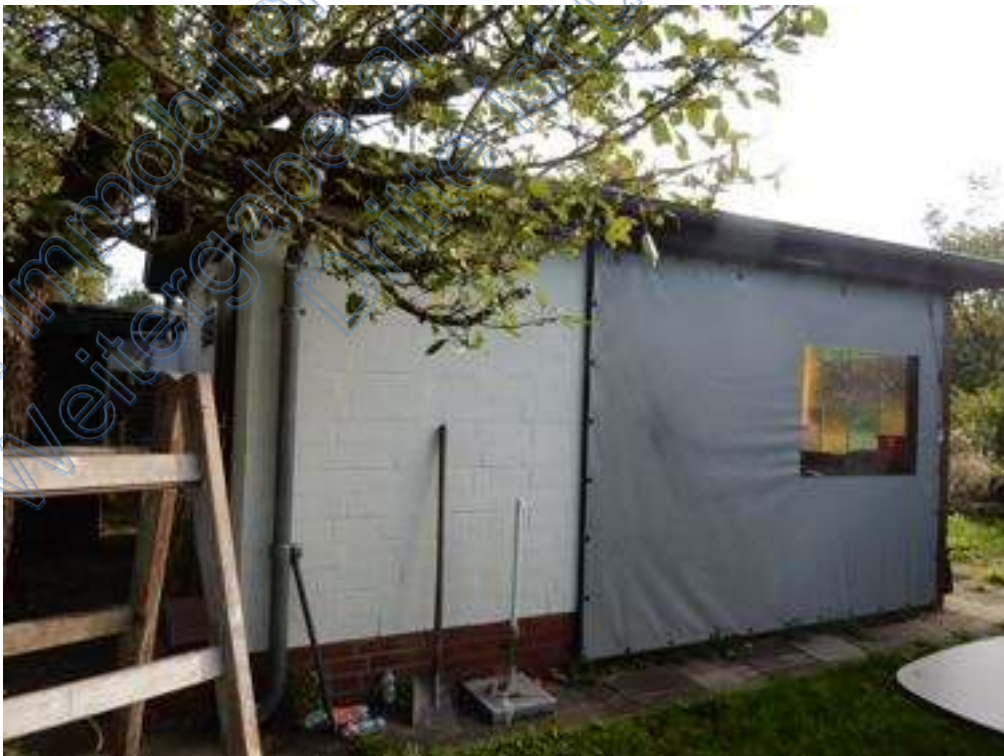
Ansicht aus Richtung Nordwesten
