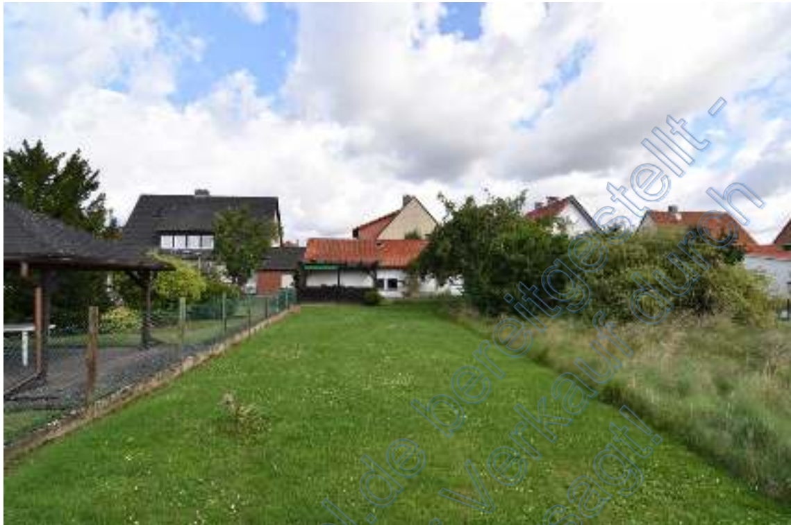
Blick von Süden auf die Gebäuderückseite
