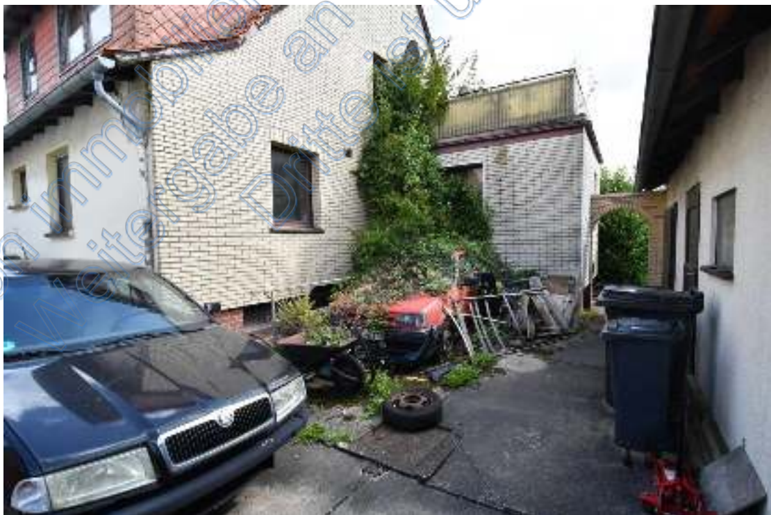
Rückwärtige Teilansicht vom Gebäude
