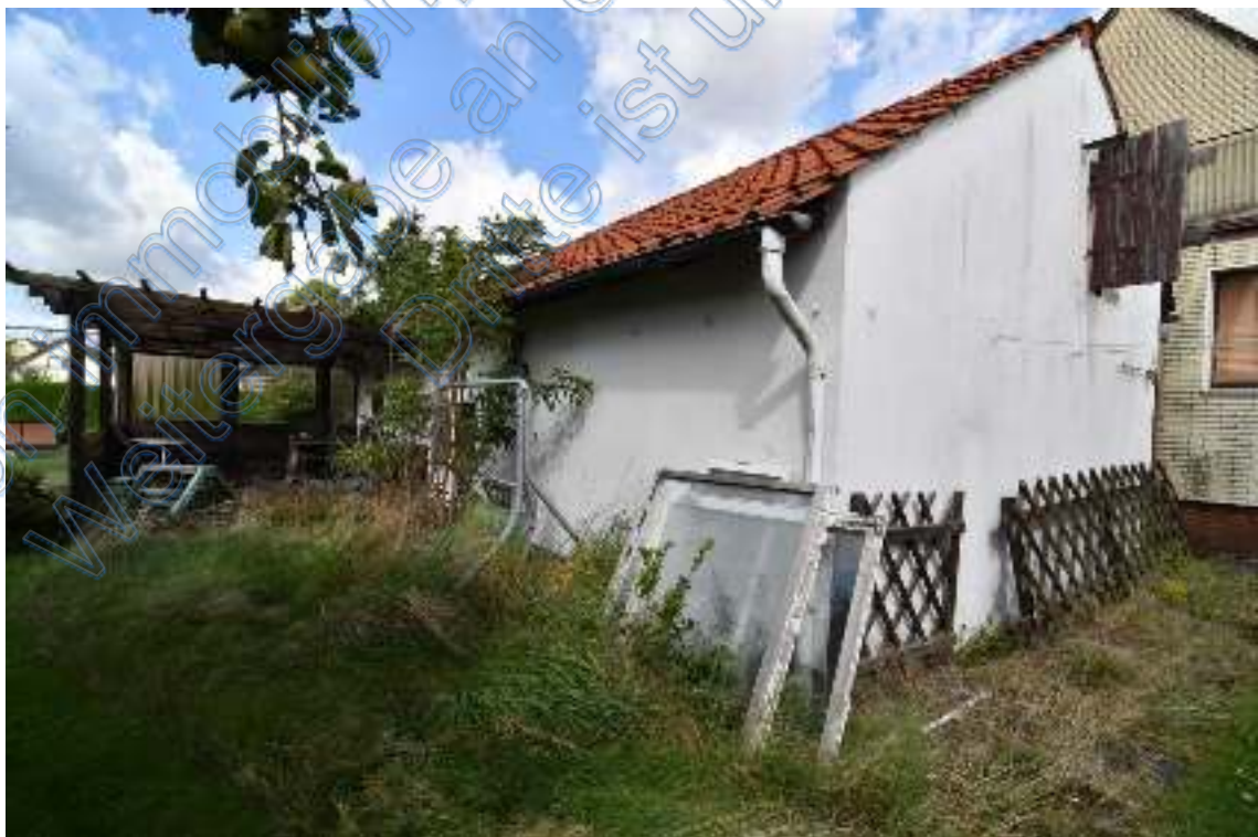
Rückwärtige Teilansicht vom Stallgebäude
