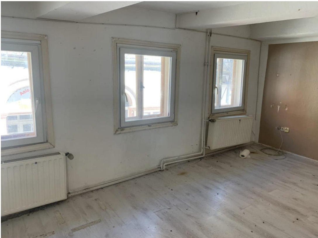
Bild 4: Doppelverglasung mit vorgesetzten Fensterelementen
