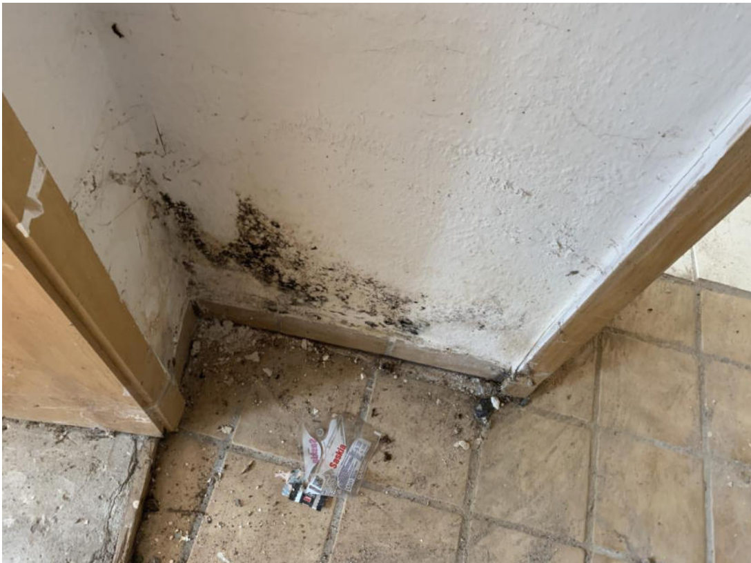
Bild 12: Schimmel im Erdgeschoss des Hinterhauses
