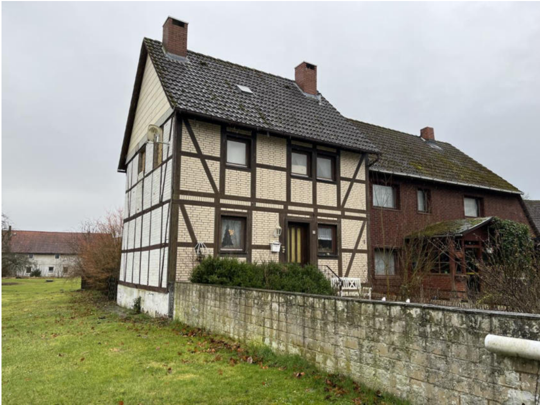
Bild 1: Eingang im Norden
