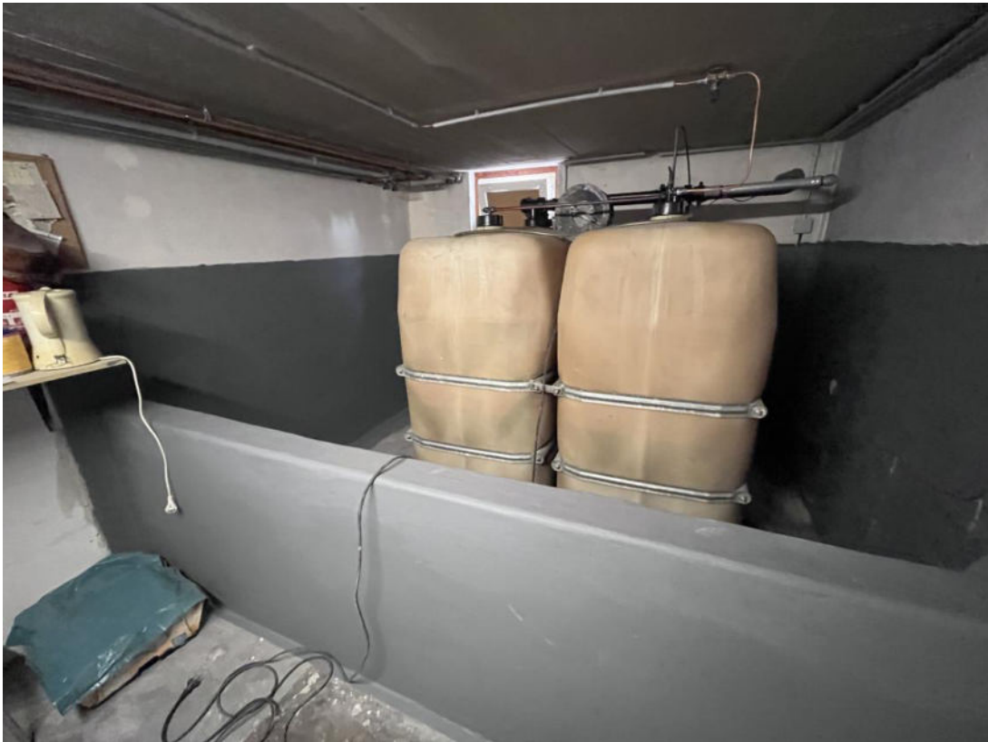
Bild 9: Kunststoff-Öltanks
