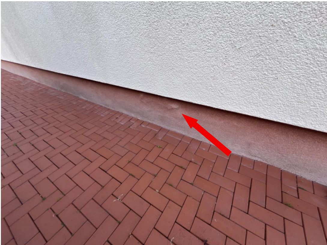
Bild 10: Feuchtigkeitsschaden im Sockelbereich
