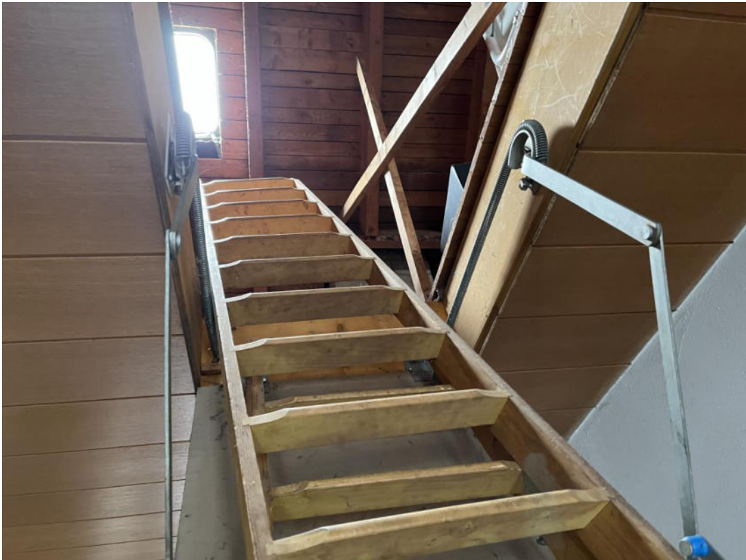
Bild 7: Treppe zum Dachgeschoss
