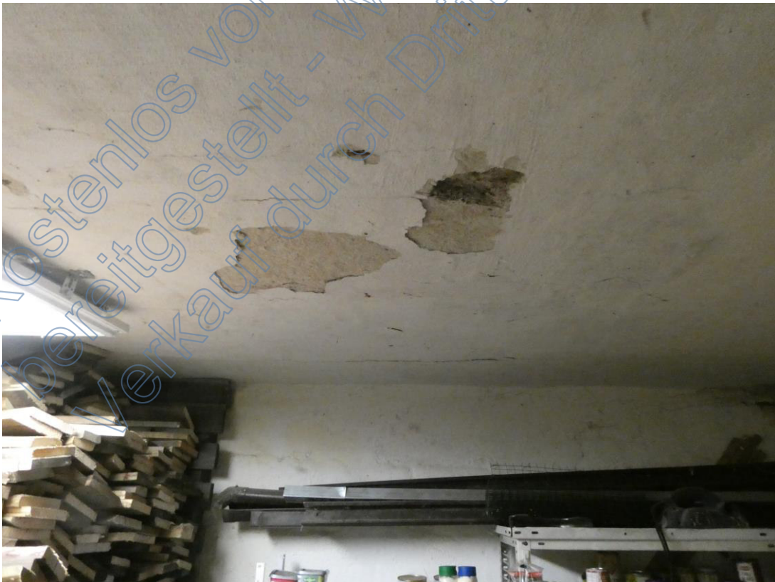
Bild 10: Putzabplatzungen an der Kellerdecke
