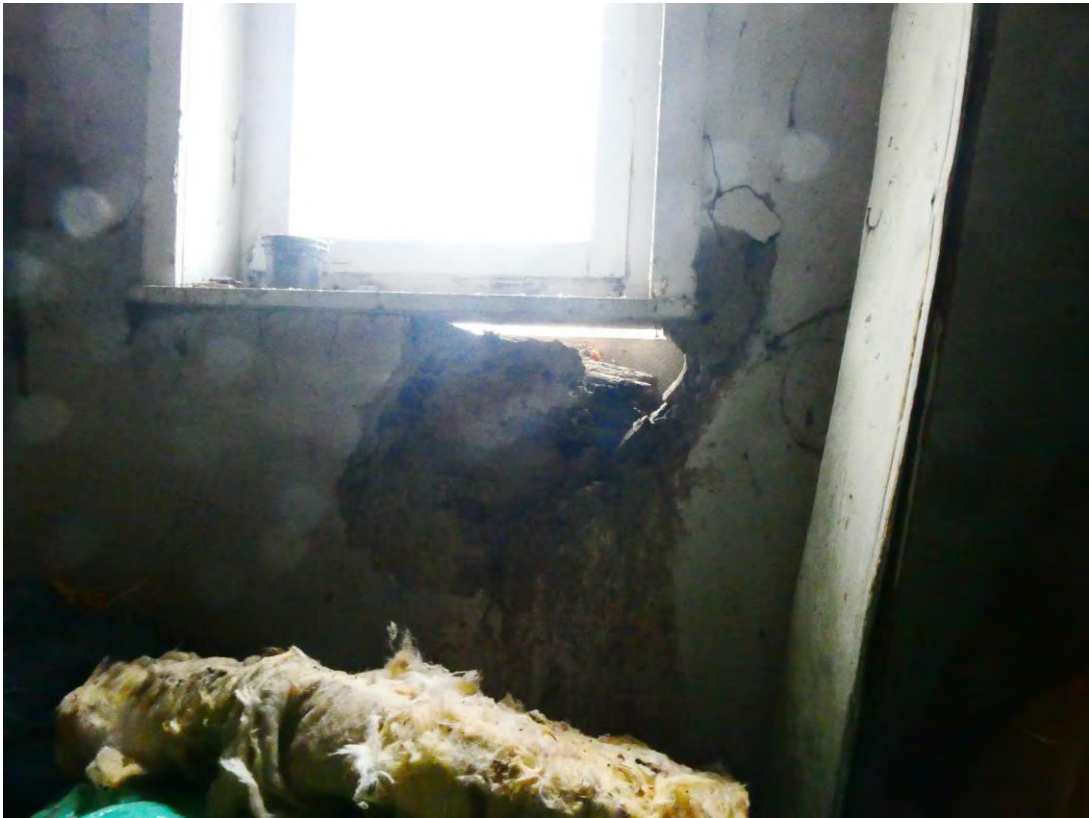
Bild 9: verfallter Brüstungsriegel, Schaden am Gefach
