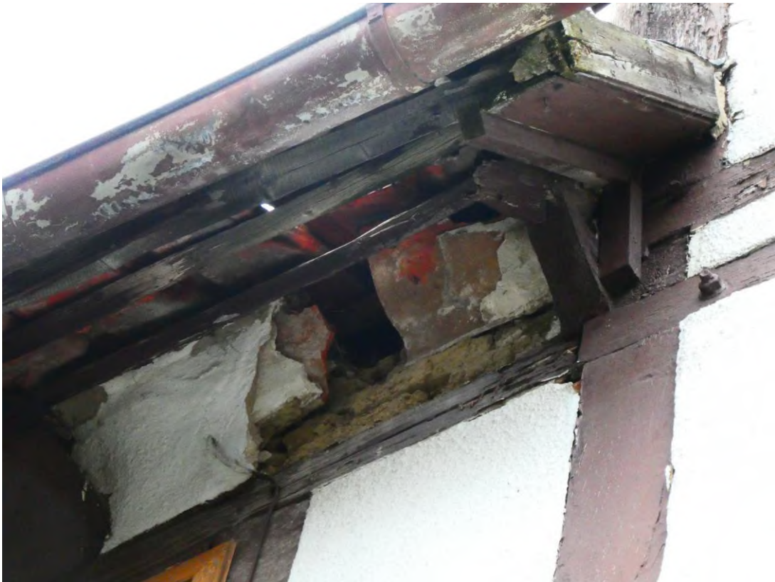
Bild 8: weiterer Schaden im Traufbereich
