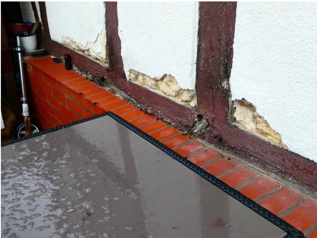
Bild 6: Schäden am Schwellholz und den Gefachen
