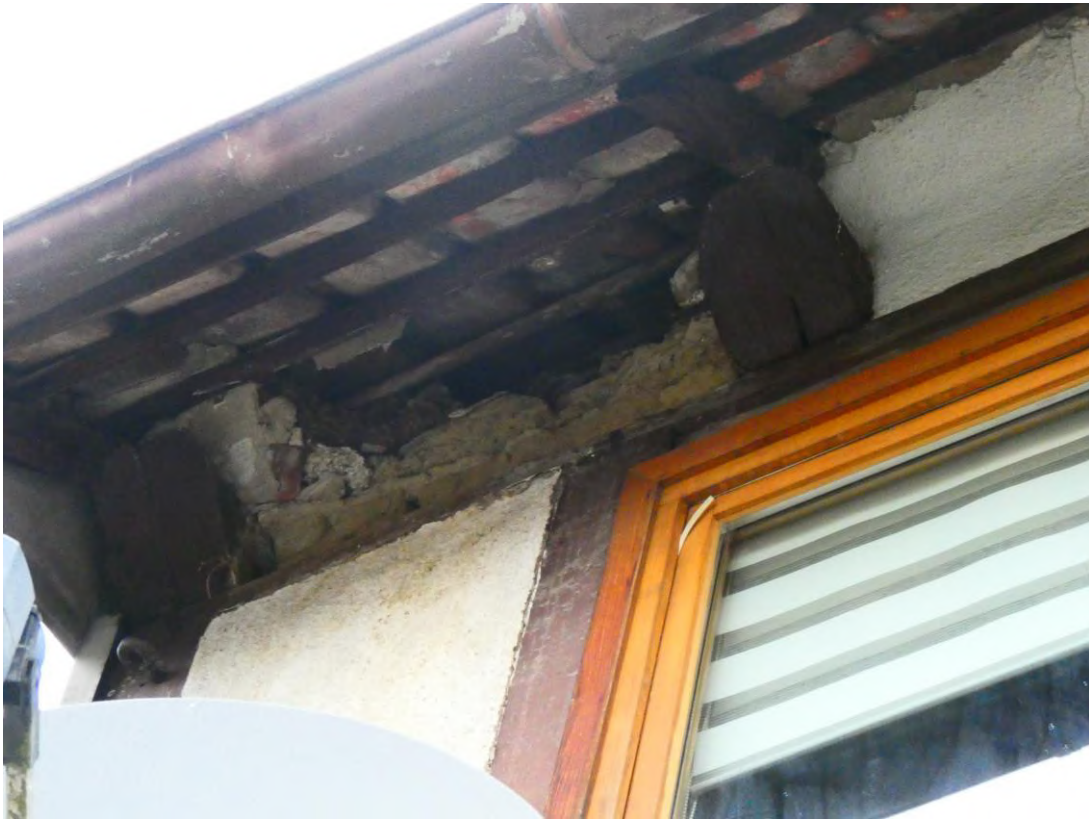
Bild 7: Schaden im Traufbereich
