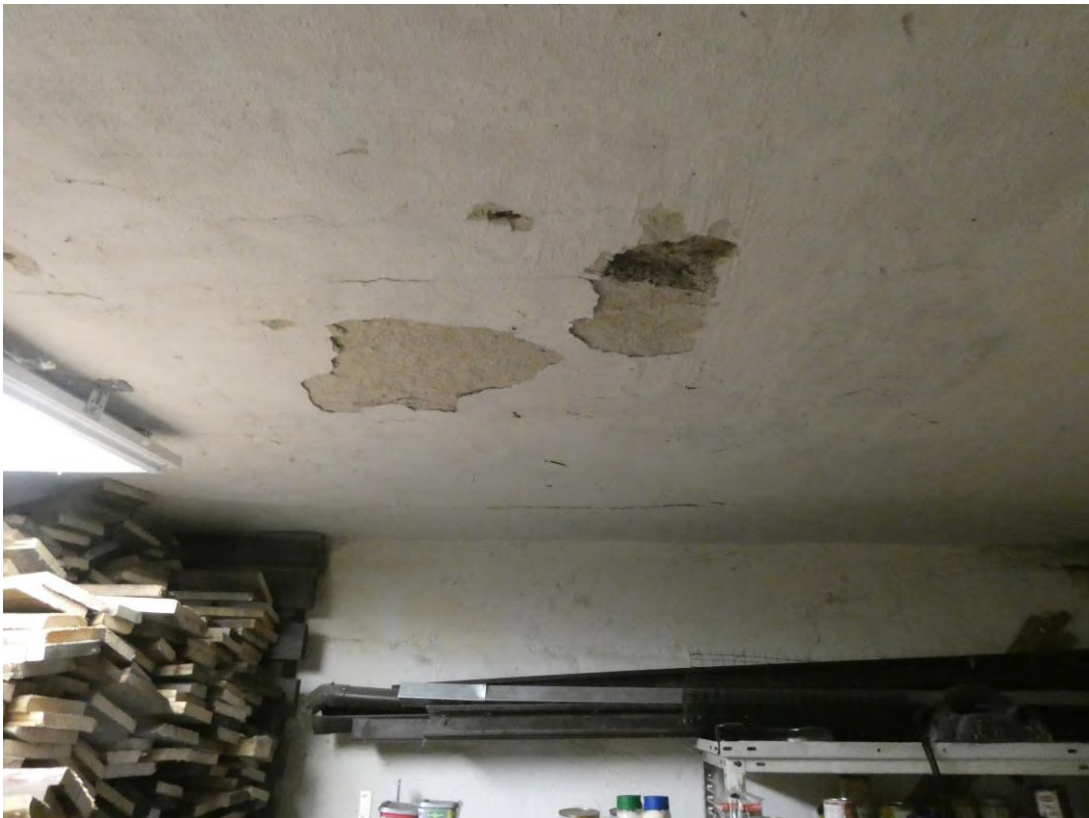
Bild 10: Putzabplatzungen an der Kellerdecke
