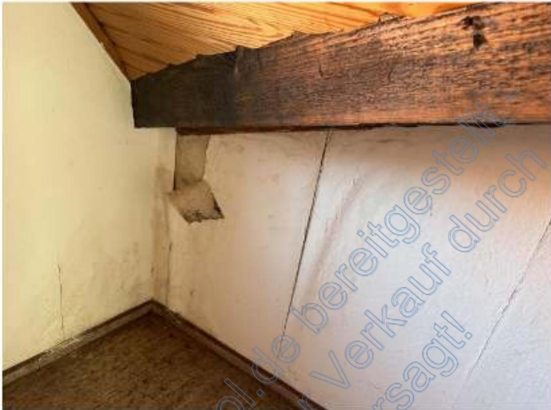
Bild 11: Mittelzimmer im Neubau (DG) mit exemplarischen Feuchtigkeitsschäden
