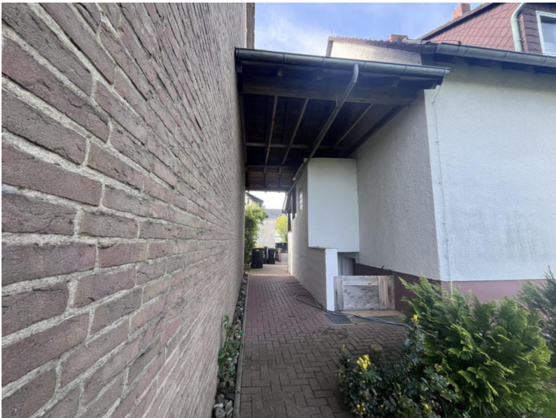
Bild 6: überdachter Durchgang zur Eingangsseite
