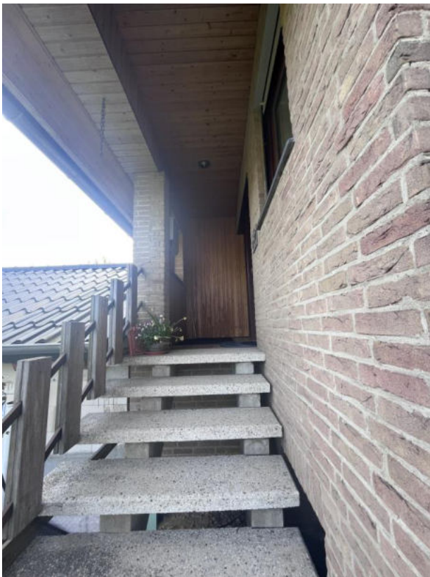
Bild 4: Eingang im Norden
