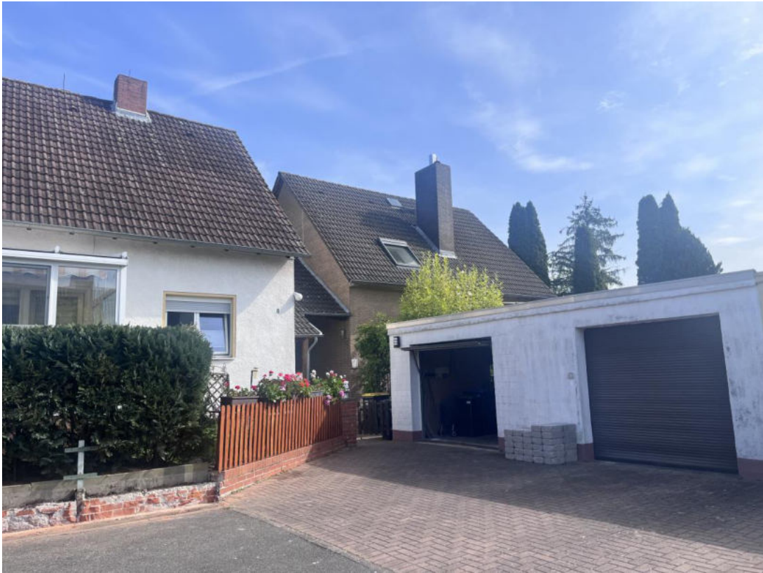
Bild 5: Fußwegverbindung vom Astenweg über das Nachbargrundstück
