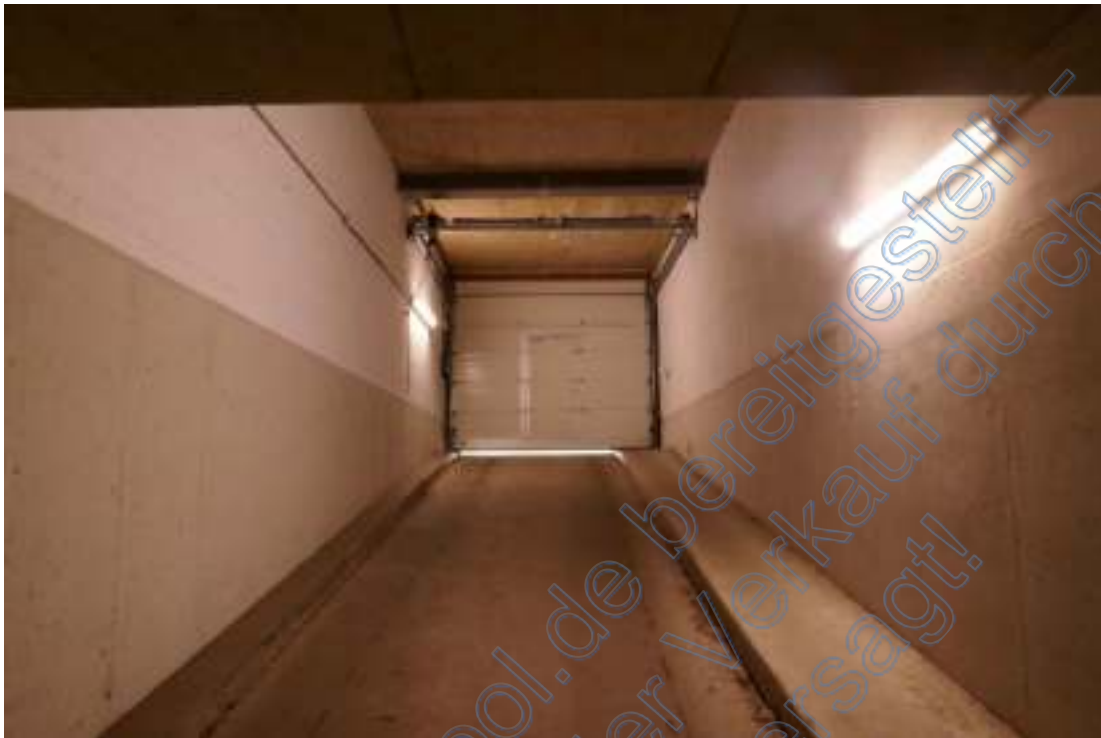
Foto 15, Zu- und Ausfahrt Tiefgarage, Untergeschoss Hindenburgstraße 83, Gemeinschaftseigentum
