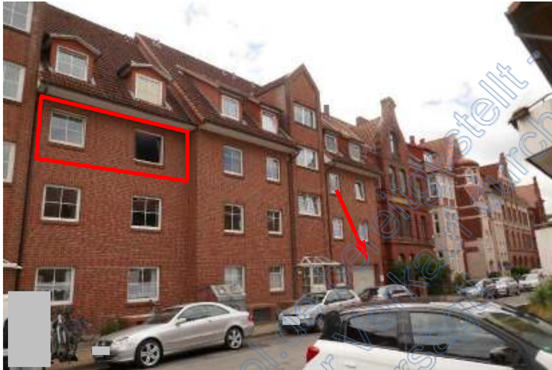
Foto 3, Hindenburgstraße, rot umrandet Wohnung Nr. 7, Pfeil weist zur Ein- und Ausfahrt Tiefgarage Hindenburgstraße 83, Nordostansicht
