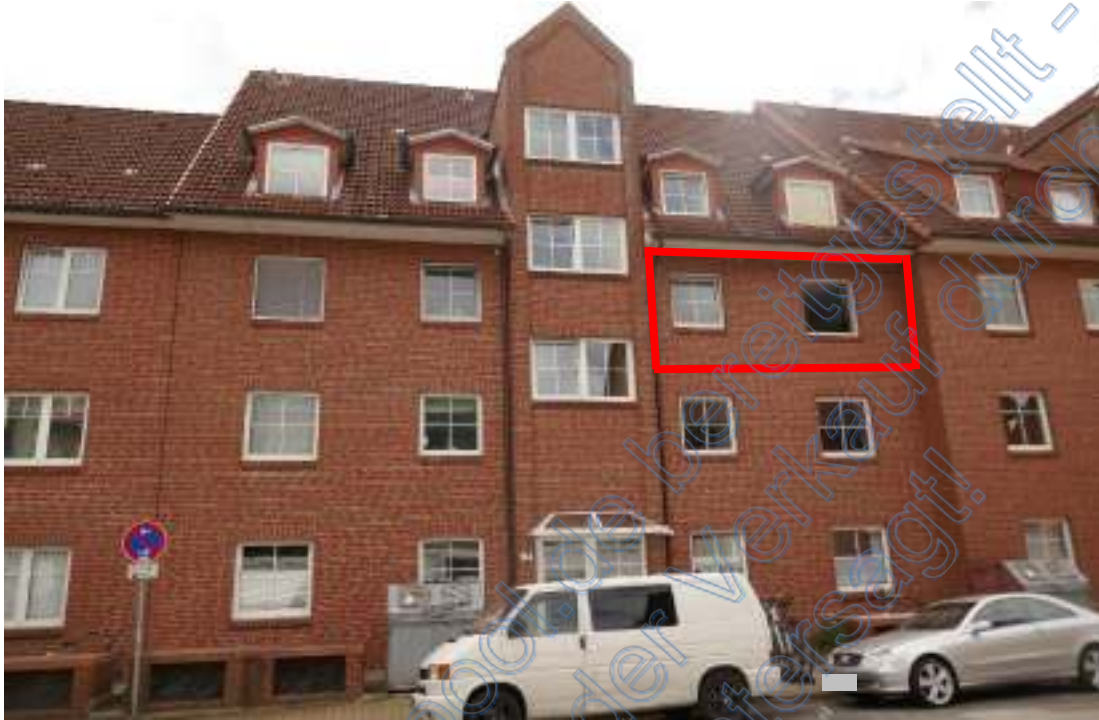
Foto 1, Mehrfamilienhaus Hindenburgstraße 84, Wohnung Nr. 7 rot umrandet, Nordansicht
