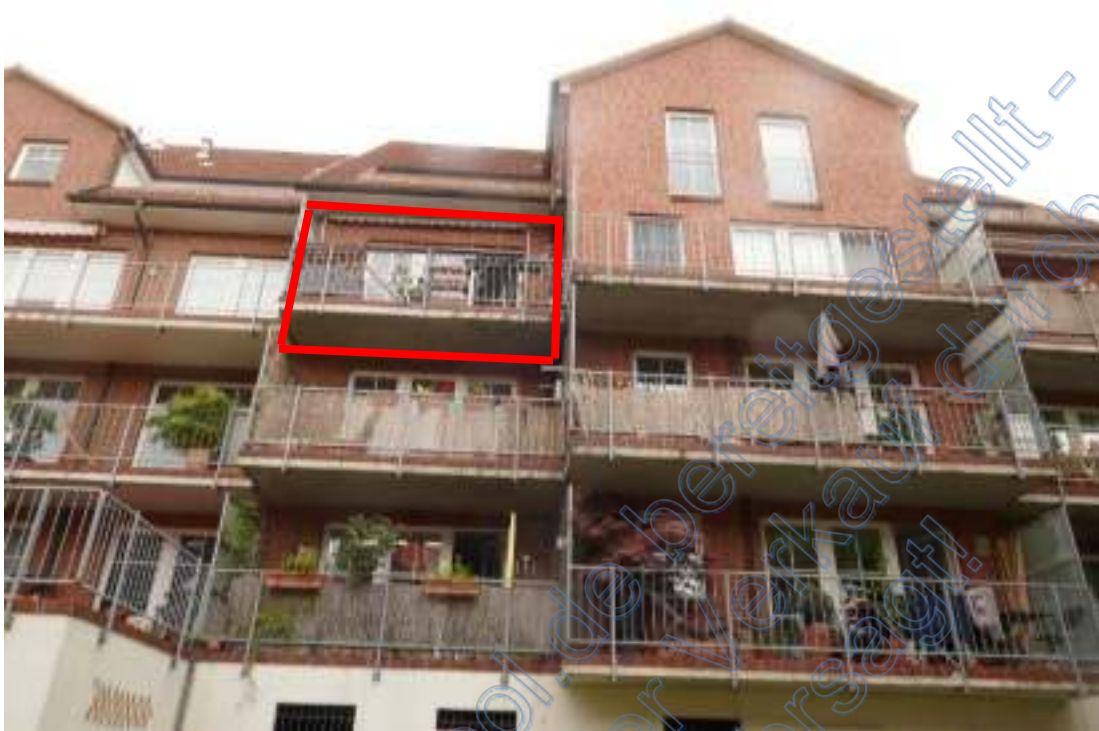
Foto 5, Südseite Mehrfamilienhaus Hindenburgstraße 84, Wohnungen mit Balkonen und Loggien im Dachgeschoss, Wohnung Nr. 7 rot umrandet, Südensicht
