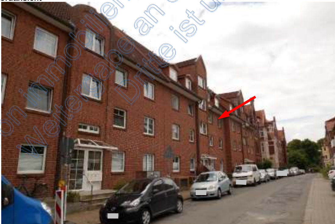
Foto 2, Hindenburgstraße, Blick nach Westen, Mehrfamilienhauszeile mit Hindenburg- straße 84, Pfeil weist zur Wohnung Nr. 7, Nordostansicht
