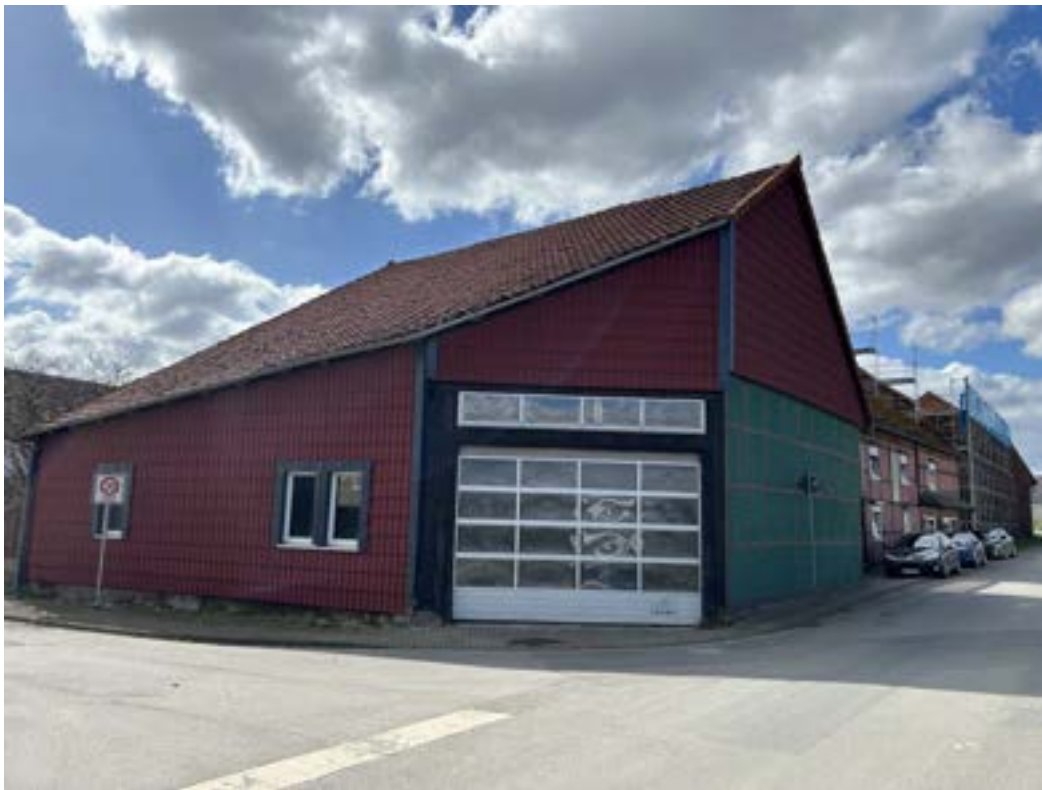
Anlage 5.3: Bild 3 Ansicht von Nordosten
