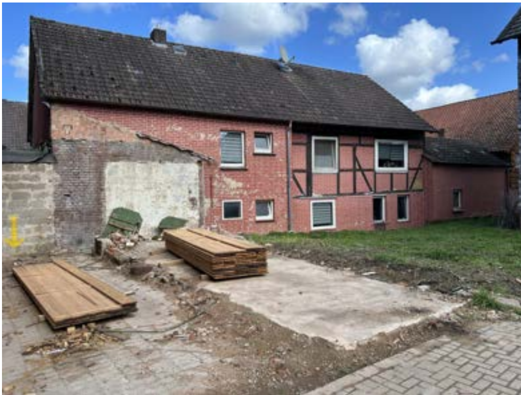
Anlage 5.1: Bild 1 Ansicht von Südwesten
