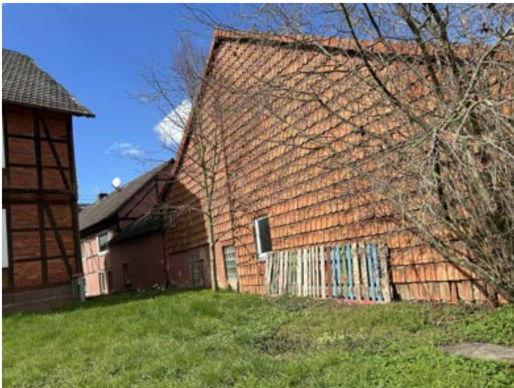
Anlage 5.4: Bild 4 Ansicht von Südosten
