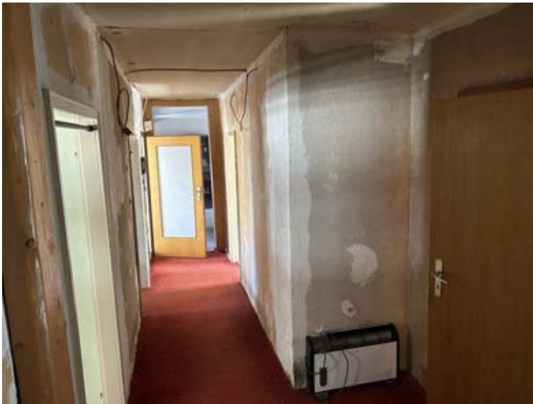
Anlage 5.7: Bild 7 Flur im Obergeschoss, teils fertig
