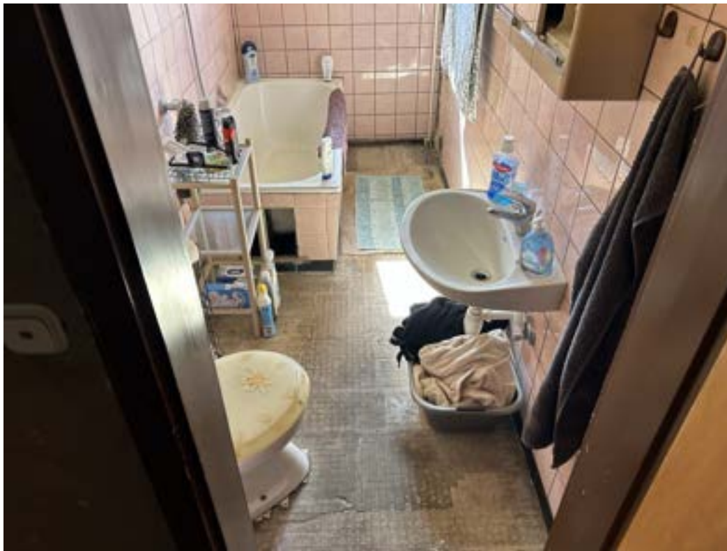
Anlage 5.5: Bild 5 Badezimmer Obergeschoss
