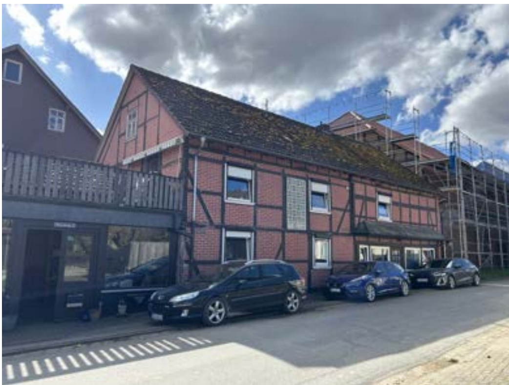
Anlage 5.2: Bild 2 Ansicht von Nordosten
