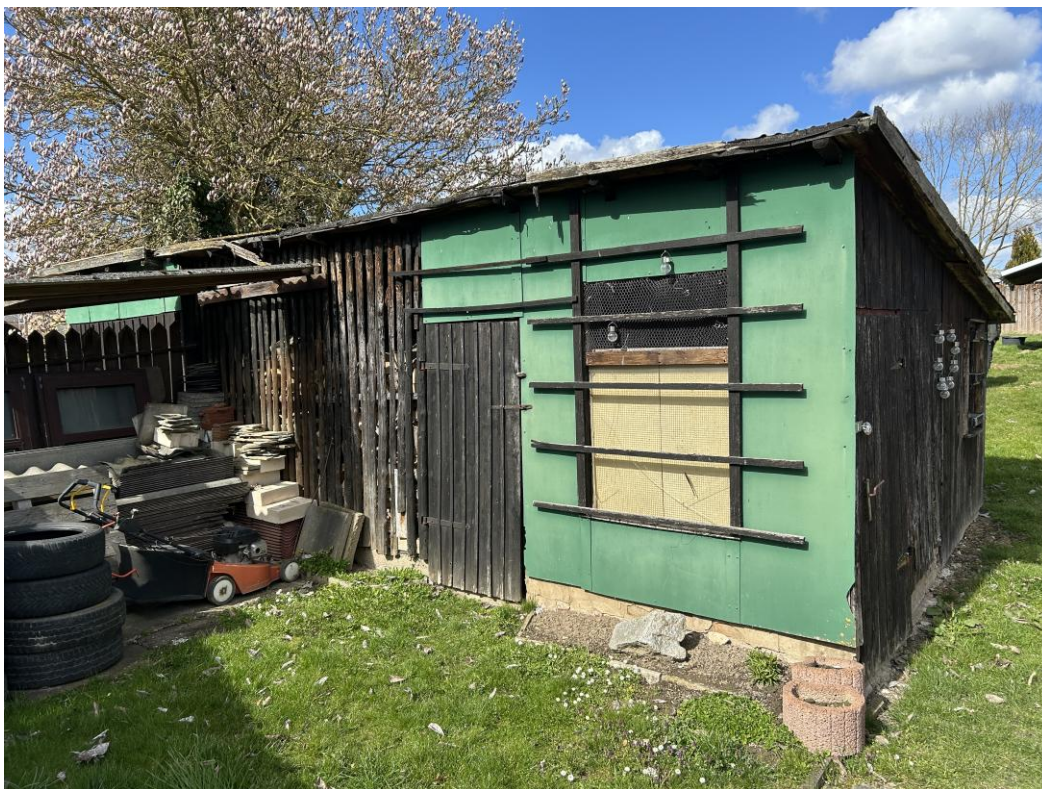
Anlage 5.2: Bild 2 Holzlager
